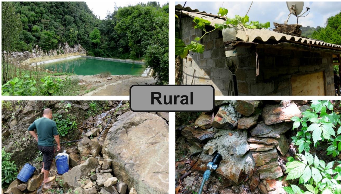
Figure 5: Dezentrale Wasserversorgung mittels Speicherbecken (oben links), aufgefangenem Regenwasser (oben rechts) und an Quellen abgefülltem (unten links) bzw. umgeleitetem Wasser (unten rechts).
