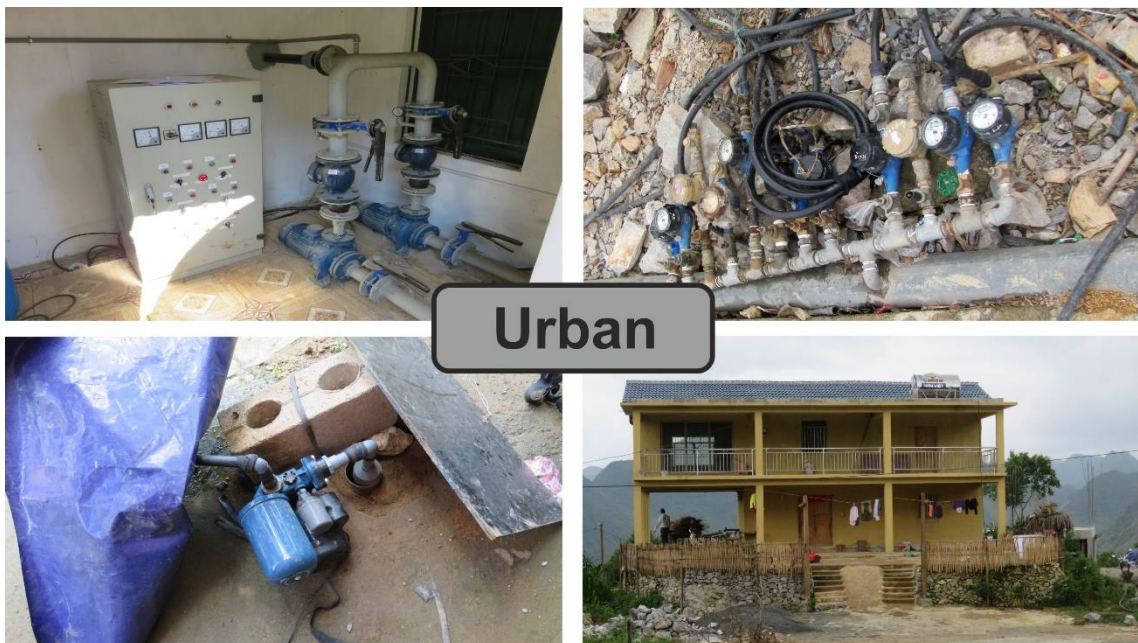
Figure 4: Zentrale bzw. semizentrale Wasserversorgung in Dong Van via Pumpbrunnen mit marodem Leitungsnetz (oben), privaten Brunnen (unten links) und Speichertanks auf dem Hausdach (unten rechts).
