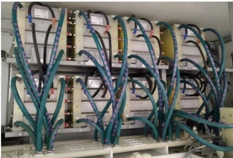
Abbildung 6: Acht Flow-Batterie-Stacks mit gut sichtbarer Verrohrung im Vordergrund
