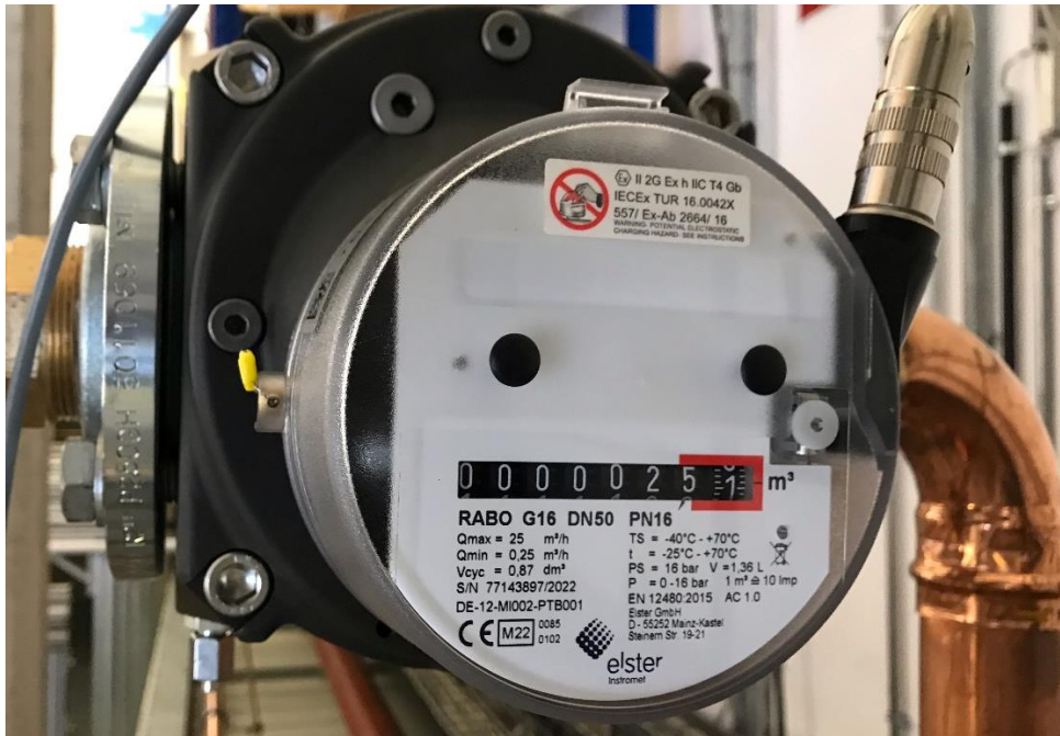
Abbildung 6-4: Drehkolbengaszähler (Foto GWI)
