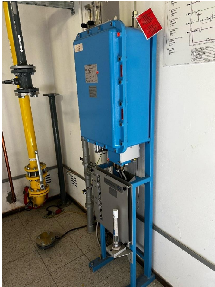
Abbildung 6-8: Gaschromatograph zur Bestimmung der Gaszusammensetzung (Foto GWI)
