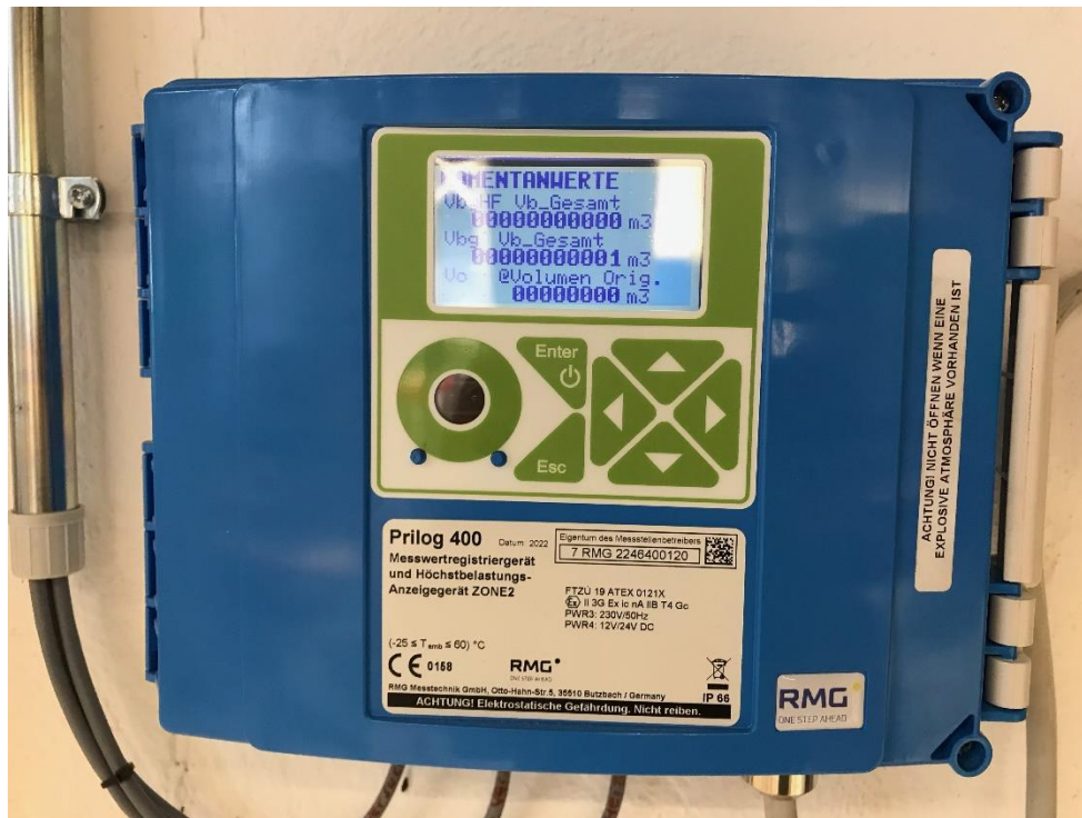
Abbildung 6-7: Logger für die Einbindung der Gaszähler ins Netzwerk (Foto GWI)
