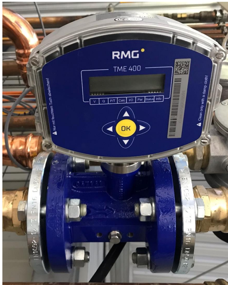
Abbildung 6-5: Turbinenradzähler für homogene Durchflussmengen (Foto GWI)
