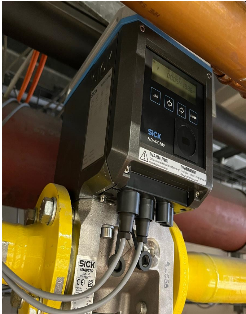
Abbildung 6-6: Ultraschallgaszähler für präzise Durchflussmessungen (Foto GWI)
