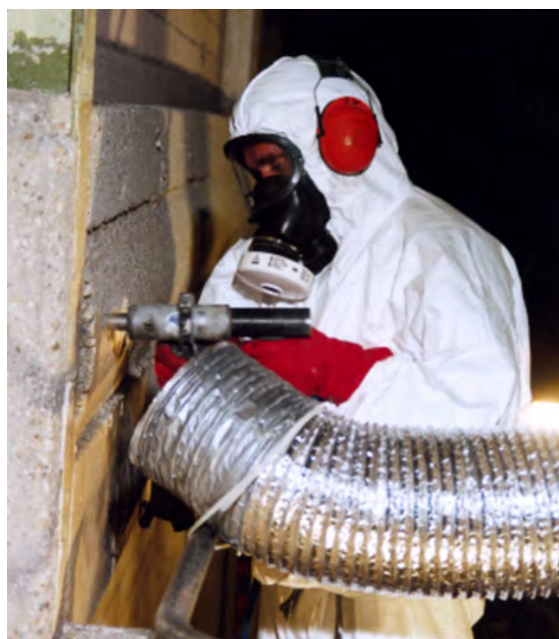
Abb. 1 Dekontaminationsarbeiten mit einem handgeführten Gerät. Foto: SAT, 2020
