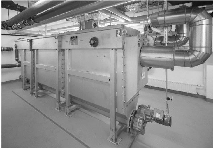
**Abbildung 5: Abwasserwärmetauscher RoWin 4S im Keller der ZSVA des Universitätsklinikums der LMU München**
