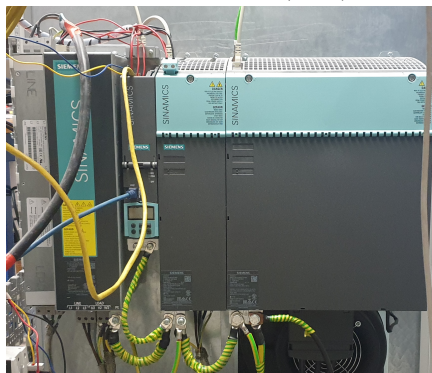
(c) Motorsteuerung der Lastmaschine bestehend aus Netzfilter, AFE, Steuereinheit und Umrichter
