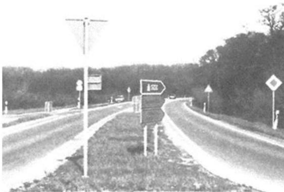
Beispiel für einen dem Fahrverlauf angepassten Fahrbahnteiler (M KLV, 1998)
