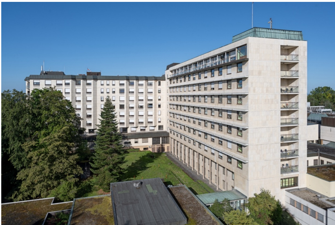
Abb. 4: Die Großstruktur des alten Sindelfinger Krankenhauses aus den 1960er-Jahren soll zu einem gemischten Stadtquartier umgebaut werden (Foto: IBA'27 / Niels Schubert)
