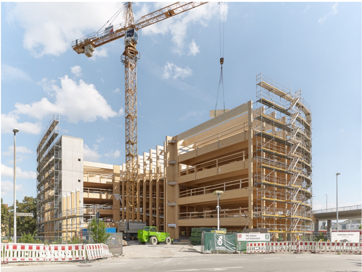
Abb. 10: Baustelle des Holzparkhaus Schwanenweg in Wendlingen am Neckar im September 2023 (Foto: Achim Birnbaum)
