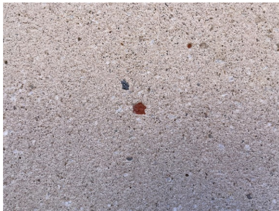
Abb. 3: Fassadenausschnitt am neuen Anbau des Rathauses in Korbach. Architekturbeton mit Anteilen rezyklierter Gesteinskörnung mit gestrahlter Oberfläche. Bild: IZB, D. Bosold
