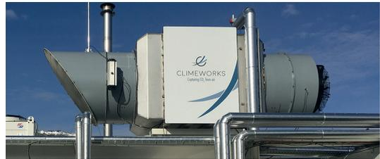
Abb. 2.2.1-3: DAC-Verfahren mit aktiver Kontaktierung und Regeneration durch wasserdampfunterstützte Temperatur-Vakuum-Wechsel-Adsorption (TVSA). Links: Zyklisches Verfahrensprinzip HICAM (2020). Rechts: DAC-1-Kollektor von Climeworks im Energy Lab 2.0 am Karlsruher Institut für Technologie (Foto: R. Dittmeyer, KIT).
