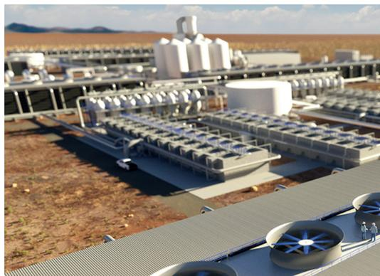
Abb. 2.2.1-7: Rendering der weltweit ersten Mega-DAC Anlage. Joint venture 1PointFive. 1 Mt CO<sub>2</sub>/a. Standort: Texas, USA (Doyle 2020).
