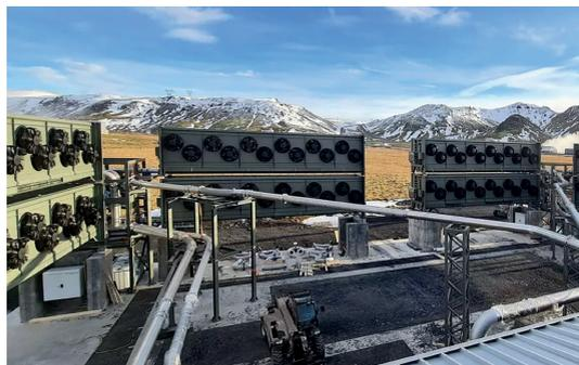
Abb. 2.2.1-6: Oben: Weltweit erste kommerzielle DAC-Anlage (Climeworks, Hinwil bei Zürich), DAC-18, 900 t CO<sub>2</sub>/a, (SCINEXX 2017). Unten: Climeworks-Anlage ORCA in Hellisheiði bei Reikjavik, 4.000 t CO<sub>2</sub>/a. Mit freundlicher Genehmigung von Climeworks.
