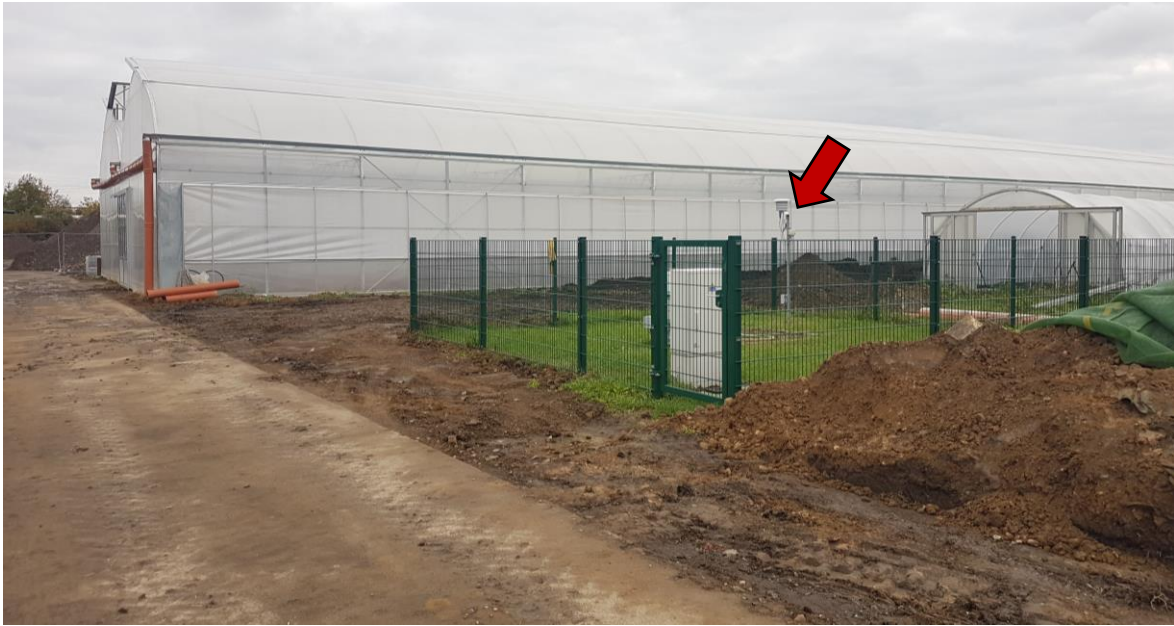
Abbildung 24: Ansicht der Station Strehlen (roter Pfeil) und ihrer Umgebung von Südwesten (Aufnahme: J. Glaß, 19.10.2022).
