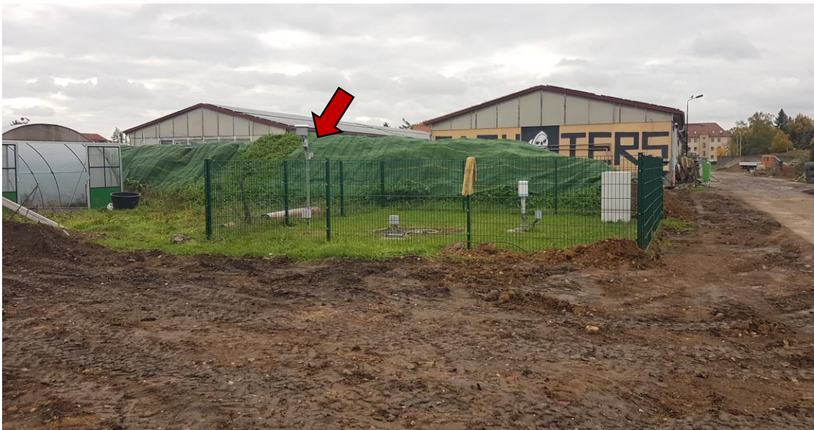
Abbildung 25: Ansicht der Station Strehlen (roter Pfeil) und ihrer Umgebung von Nordosten (Aufnahme: J. Glaß, 19.10.2022).
