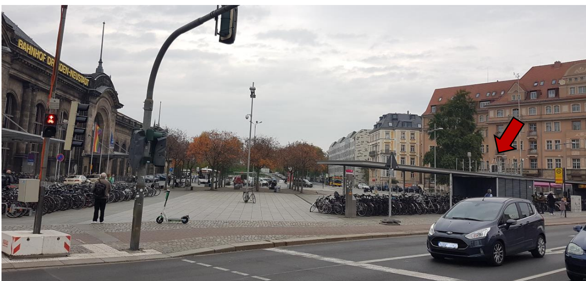
Abbildung 21: Ansicht der Station Nord (Containerdach, roter Pfeil) und ihrer Umgebung von Südwesten (Aufnahme: J. Glaß, 18.10.2022).
