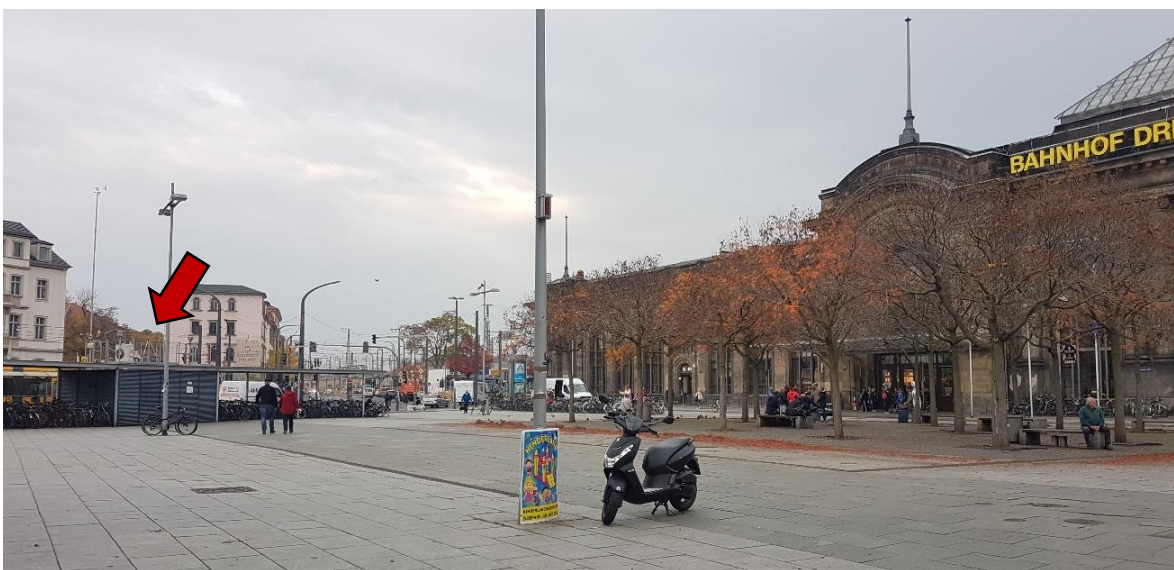
Abbildung 20: Ansicht der Station Nord (Containerdach, roter Pfeil) und ihrer Umgebung von Nordosten (Aufnahme: J. Glaß, 18.10.2022).
