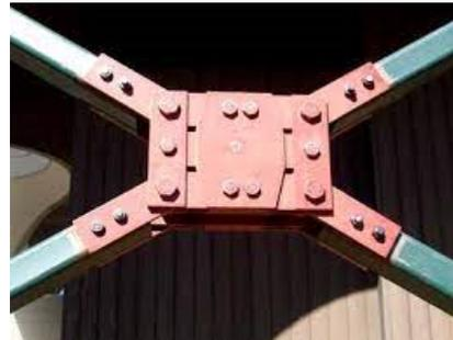
Abbildung 2.26: Anordnung eines Reibungsdämpfers nach Pall in einem Aussteifungsverband des 14-story tower in Seattle (Pall et al. 2006)
