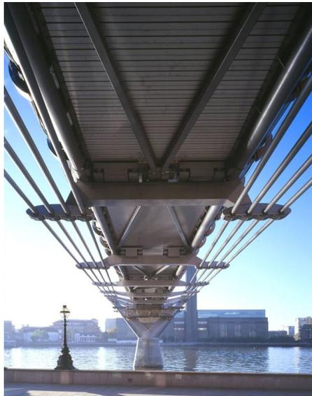
Abbildung 2.22: Einbausituation von Tuned-Mass-Dampfern (TMD) zur Reduzierung der vertikalen Schwingungsamplituden der Millennium Bridge; Anbringung von zwei TMDs an jedem Querträger an der Unterseite des Brückendecks (© GERB GmbH & Co. KG)
