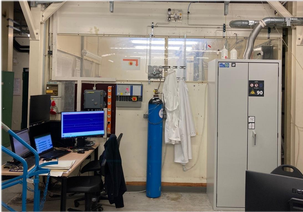
Abb. 83: MURSS-2 Einhausung mit Prozessleitwarte (links) und Gasflaschenschrank für CO und H 2 (rechts).
