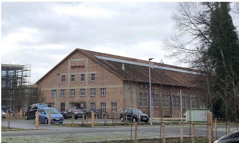
Denkmalgeschützte Reithalle Achern mit integrierten, lichtdurchlässigen Photovoltaikpaneelen
