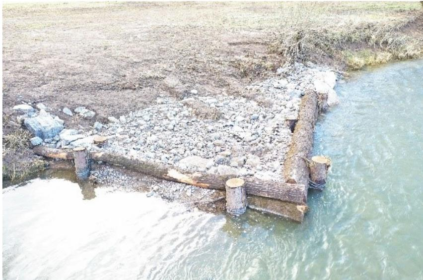
Figure 6.7: Implementation of a triangular groyne with natural materials in a river restoration project in the Neckar near Börstingen, Source: Regierungspräsidium Tübingen, 2023. URL: <https://rp.baden-wuerttemberg.de/rpt/abt5/ref532/neckar-natur-weg/seiten/buhnen/> (accessed on 31.12.23).
