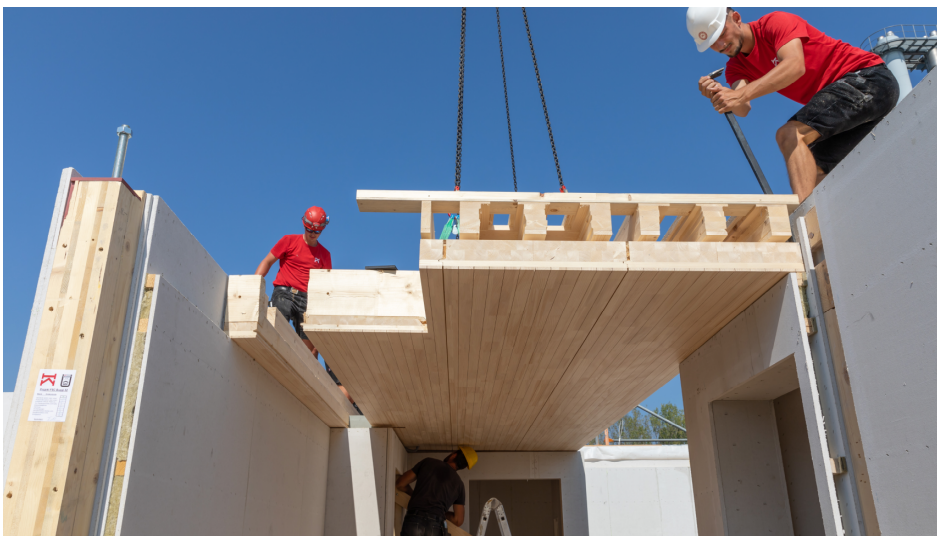
Abb. 20: Deckenelement wird aufgelegt
