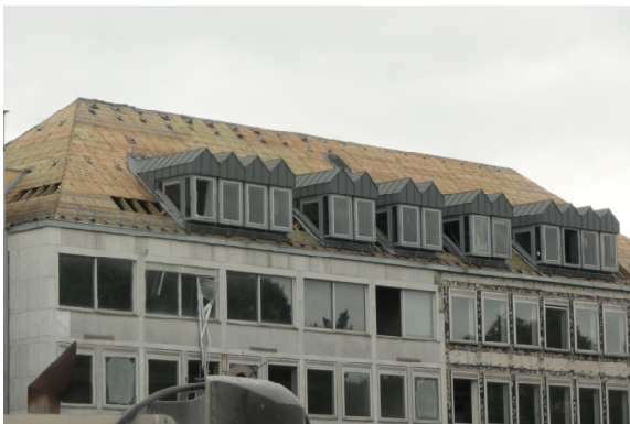
Abb. 5: Ostflügel nach dem Entfernen der Schiefereindeckung
