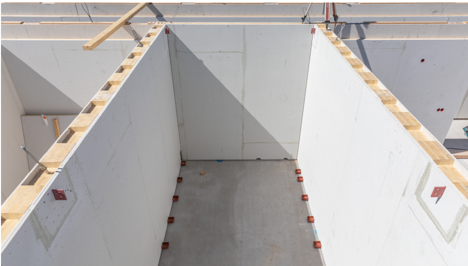
Abb. 17: 1. OG des Treppenhauses in Massivholzbauweise
