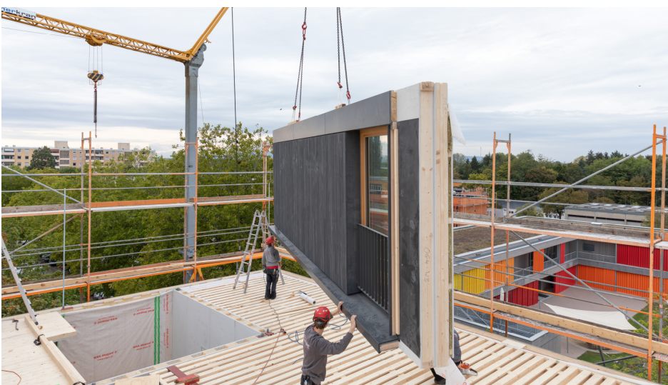
Abb. 18: Außenwand mit fertiger Fassade und Bauteilstoß
