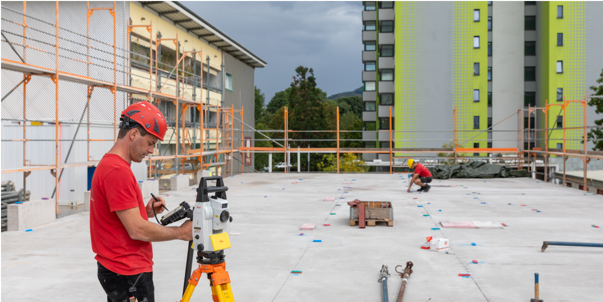
Abb. 16: Einmessen mit dem Tachymeter
