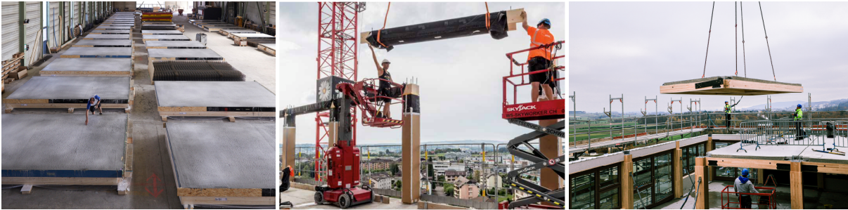
Abb. 11: Produktions- und Montagebilder der Projekte (v.l.n.r.) „Suurstoffi 22“, „Arbo“, „Zwhatt“. [Bildnachweis v.l.n.r: Markus Bertschi, Pirmin Jung Ingenieure, Charles Binck].
