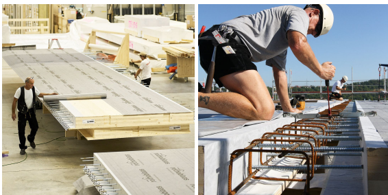
Abb. 31: Vorfertigung und Montage des Plattenstoßes
