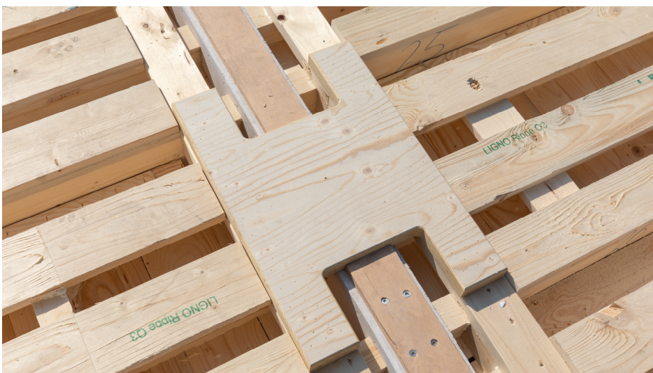
Abb. 21: „H-Element“ zur Aufnahme und Ableitung der Schubkräfte
