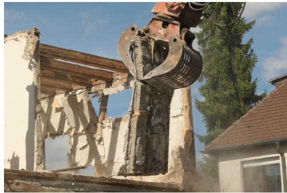
Abb. 3: Siedlungshaus in Stockwerksbauweise im OG und Abbruchprozess
