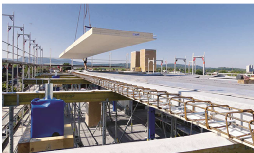
Abb. 32: Versetzen der Deckenelemente mit SPIDER-Connector und Holz-Beton-Verbindung (Plattenstoß)
