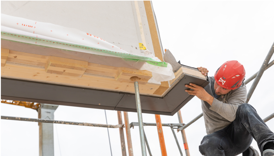
Abb. 19: Einführen des Wandelements in die Zugstangen
