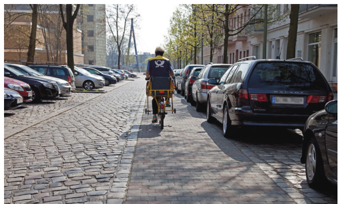
ABB.7: FÜR RADVERKEHR OPTIMIERTER WEG AUF EINER KOPFSTEINPFLASTERSTRASSE, BERLIN (HERRMANN & STEINMETZ, 2014)
