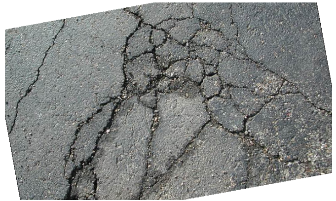
ABB. 4: ASPHALT MIT RISSEN
