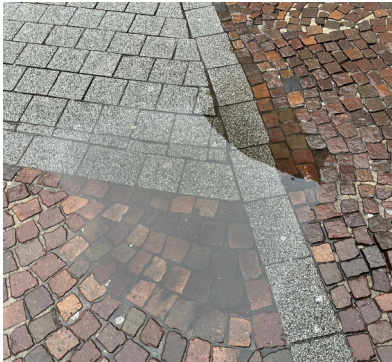
ABB. 8: PFÜTZENBILDUNG BEI MATERIAL-WECHSEL
