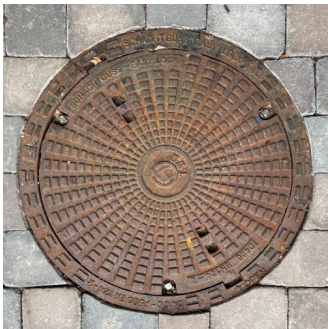
ABB. 3: SCHACHTDECKEL OHNE BE- UND ENTLÜFTUNG
