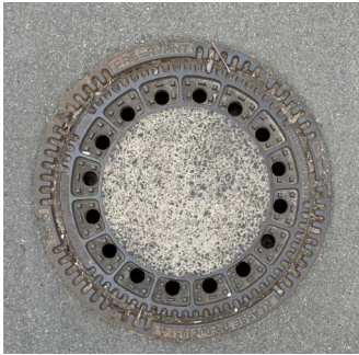
ABB. 2: SCHACHTDECKEL MIT BE- UND ENTLÜFTUNG
