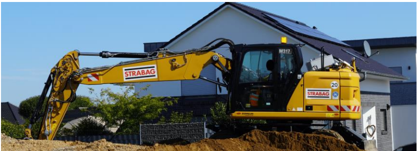
Abbildung 3.1: Bagger aus der Fallstudie
