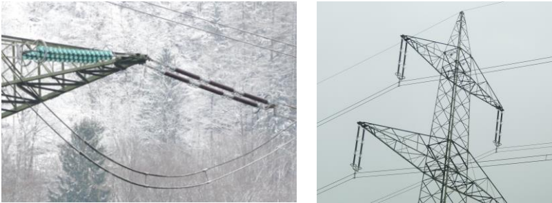
Abbildung 4: links: Abspannmast mit Mehrfachketten aus Glas-Kappenisolatoren und TLI, rechts: Tragmast mit doppelt ausgeführten TLI-Mehrfachketten
