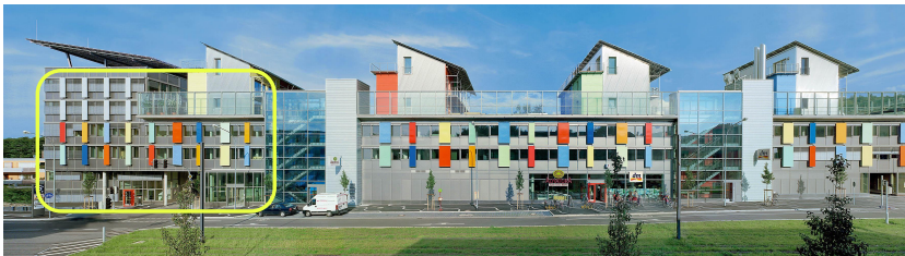
Abb. 5.1: Blick auf die Westfassade des Sonnenschiffs in Freiburg. Die farbige Umrandung markiert den Gebäudeteil, in dem die beiden analysierten Räume liegen [106].
