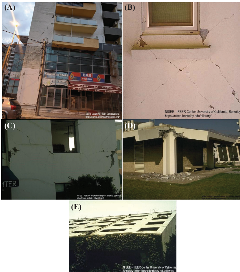
Abbildung IV.14: Beispielfotos für schwer zu lösende Klassifizierungsaufgaben im Crowdmap-Webservice [80]: (A) Leichter Schaden [64], (B) mäßiger Schaden [134], (C) starker Schaden [134], (D) sehr starker Schaden [134] und (E) Zerstörung [134]
