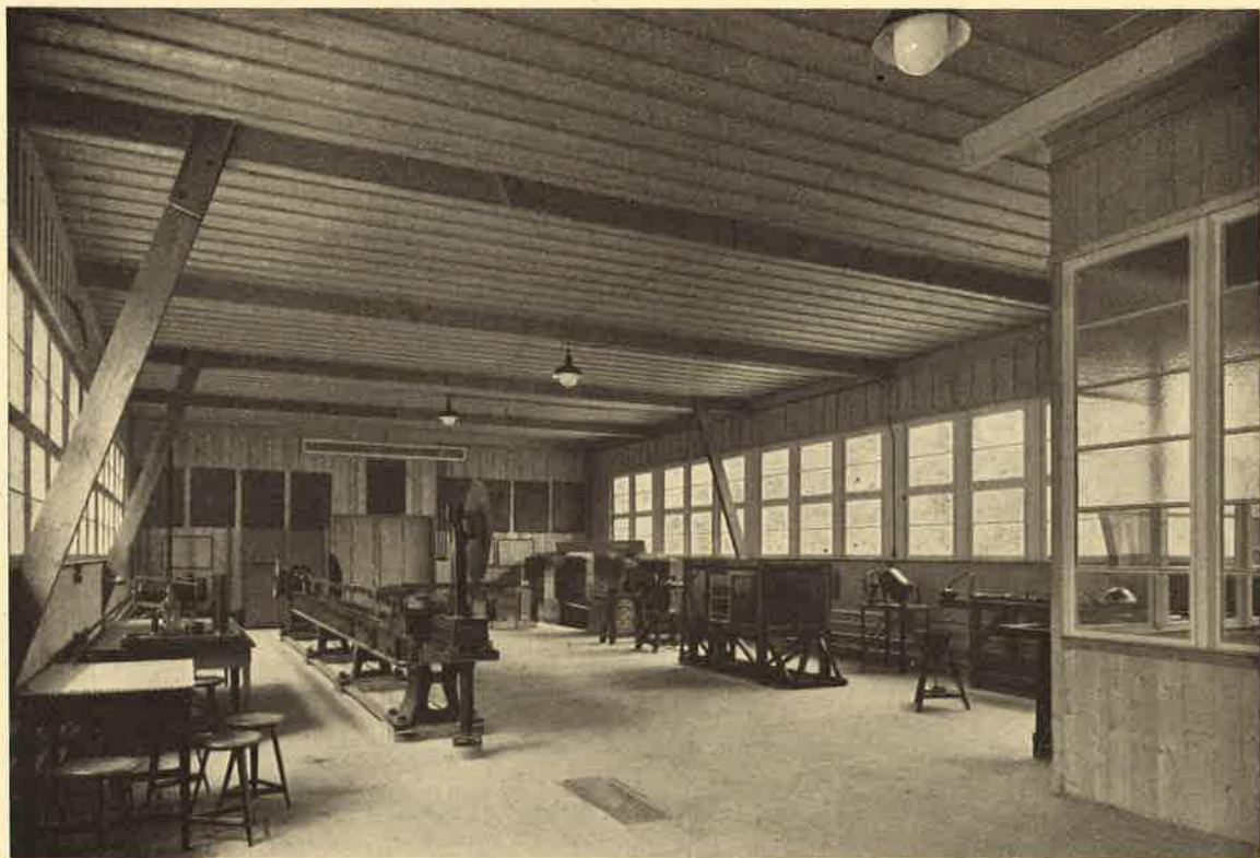
Innenansicht der neuen Holzhalle der Versuchsanstalt mit der liegenden 20-t-Maschine, auf welcher die Versuche mit den genagelten Bohlen durchgeführt wurden.
