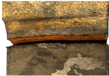
(b) Draufsicht auf den gerissenen Nahtübergang
