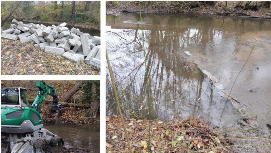
Abbildung 4-5: Verwendete Granitbausteine (oben links) zur Verpressung im ufernahen Bereich (unten links) und fertiggestellte Lenkbuhne direkt nach dem Einbau (rechts)
