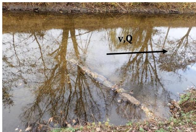
Abbildung 3-16: Lenkbuhne aus Steinen an der Alb in Karlsruhe bei einem Abfluss von etwa MNQ (eigene Abbildung)
