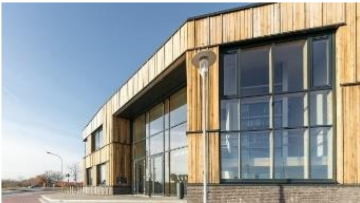
Abbildung 17: Verwaltungsgebäude Neustadt in Holstein 12
