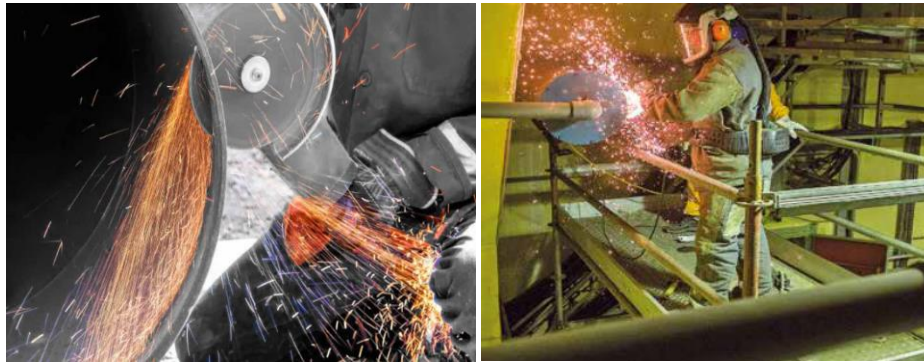
Abbildung 3.6: links: Rohraußentrennung mit Winkelschleifer [69]; rechts: Anwendung Winkelschleifer im KGR [70, S. 51]
