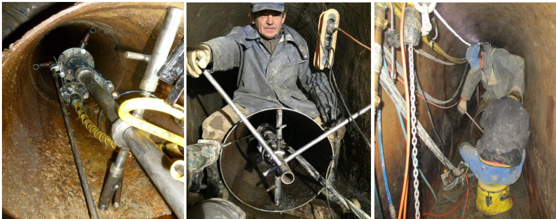
Abbildung 3.9: Rohrintrennung einer schwer zugänglichen Rohrleitung in einem Stollen mittels Prototyp Kübler Rohrtrenntechnik GmbH [74]
