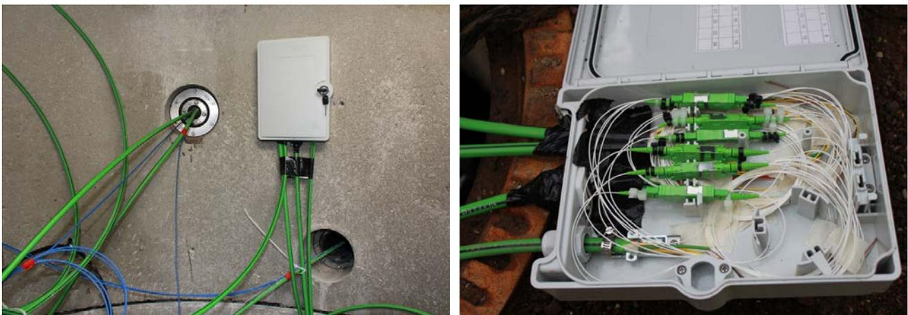
**Abbildung 9:** wasserdichte Boxen zum Schutz der Anschlüsse im Schacht.
