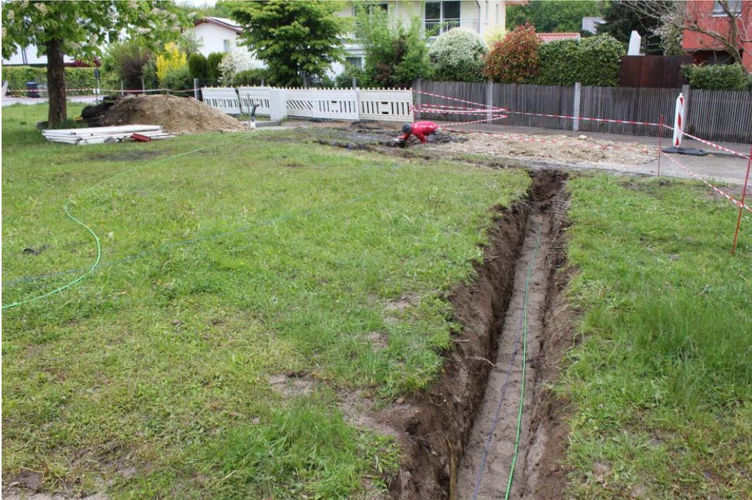
**Abbildung 8:** Verlegung von Glasfaserkabeln an der Oberfläche in einem 80 cm breiten Graben rund um den Park. Der Betonschacht enthält alle Kabelenden und das Geophon.
