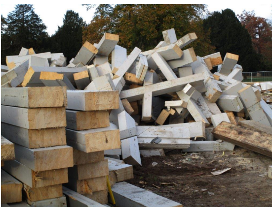
Abb. 9: Selektiver Abbruch im November 2015
