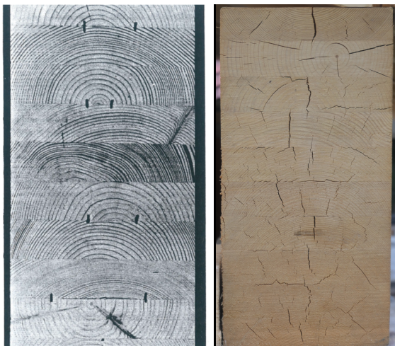
Abb. 15: Prüfkörperquerschnitt eines Brettschichtholzes mit inneren (latent) Quersugrissen infolge äußerer Feuchteeinwirkung, Hirnholz abgedichtet, Rissbreite = jeweiliger Abstand zwischen zwei Markierungen, Quelle [33] (links) und Hirnholz eines im Alpenraum verbauten Brettschichtholzträgers mit natürlicher äußerer Rissbildung (rechts)
