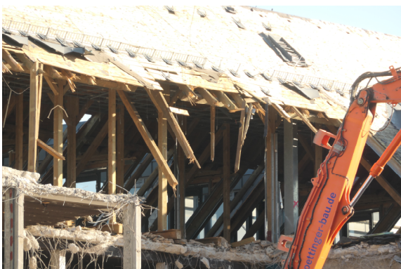
Abb. 6: Dachwerk des Ostflügels während des Abbruchs
