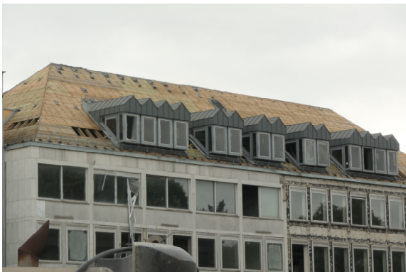
Abb. 5: Ostflügel nach dem Entfernen der Schiefereindeckung
