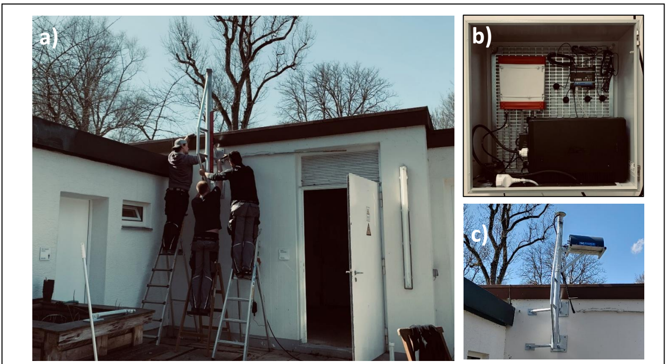
Abbildung 3: GNSS-Station Maria-Einsiedel-Bad mit Antennenhalterung (a, c) und Schaltschrank mit Receiver, GSM-Router und USV-Anlage (b). An der Antennenhalterung ist eine Plattform für einen C-Band Transponder angebracht (c). Bildquelle: Ambrus.
