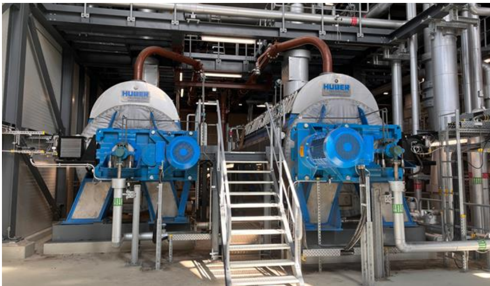
Abbildung 1: Scheibentrockner zur Teiltrocknung von 130.000 t entwässertem Klärschlamm pro Jahr vor einer Wirbelschichtverbrennung mit einer Nahwärmeauskoppelung von rund 5.000 kW bei 85-90°C (HUBER 2022)
