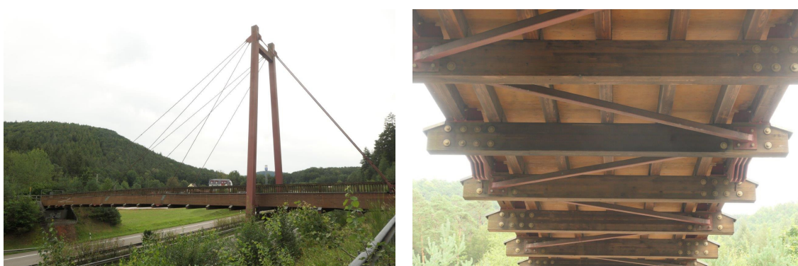
Abbildung 22: Zurückzubauende Fuß- und Radwegbrücke über die B10 bei Ruppertsweiler (links) sowie Längs- und Querträger aus Lärchenschnittholz bzw. -brettschichtholz mit hohem qualitativen Wiederverwendungspotenzial (rechts)
