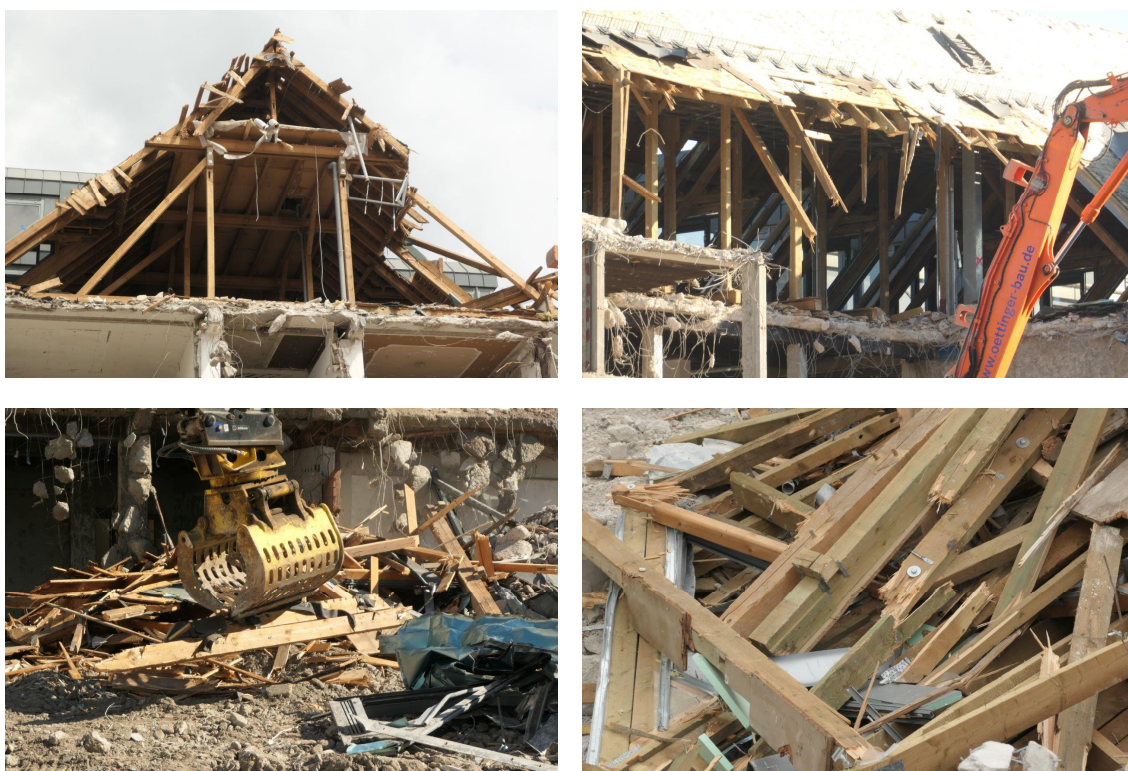
Abbildung 16: Dachwerk des Süd- und Ostflügels während des selektiven Abbruchs (oben) und Zustand des aus dem Gefüge gerissenen Holzes (unten)
