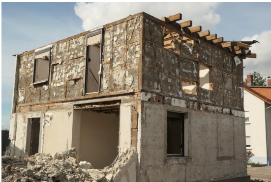
Abbildung 20: Siedlungshaus mit Stockwerksbauweise im OG und Abbruchprozess
