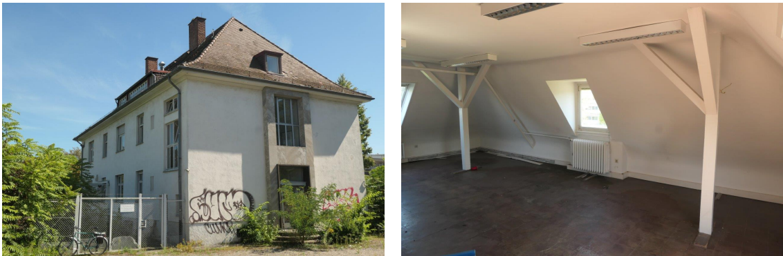
Abbildung 25: Aufgegebenes Gebäude (links), Ständer und Kopfbänder im Dachgeschoss (rechts)
