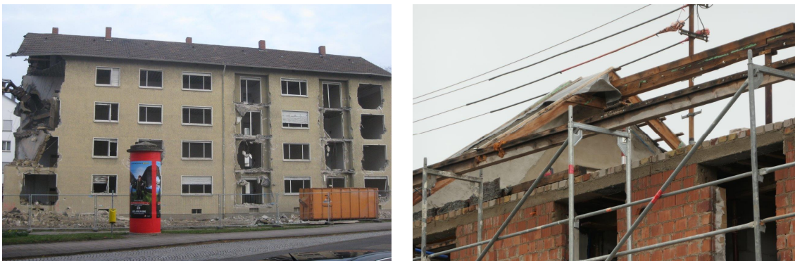
Abbildung 27: Beispiel für einen selektiven Abbruch eines Wohnhauses im Jahre 2010 (links) und für eine Demontage eines Dachstuhlgerüsts im Jahre 2023 (rechts)
