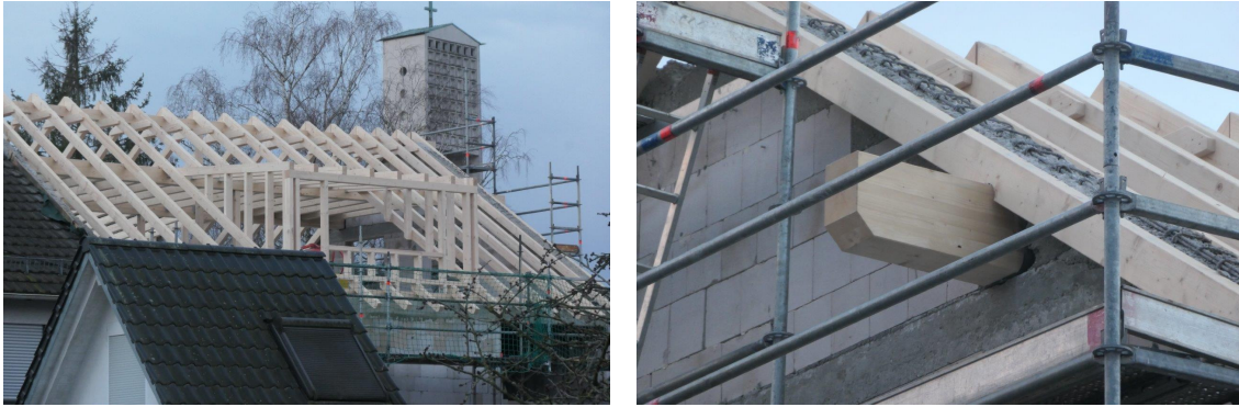
Abbildung 26: Im Jahre 2024 neu aufgerichteter Dachstuhl (links) und Sparrenkerve oberhalb der Mittelpfette (rechts)
