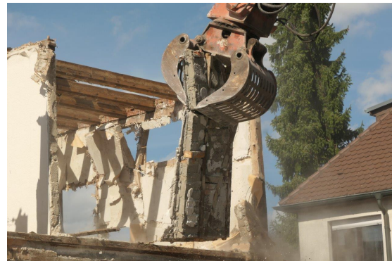
Abbildung 20: Siedlungshaus mit Stockwerksbauweise im OG und Abbruchprozess
