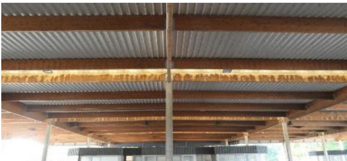
Abbildung 49: Grenzübergang Scheibenhard (Frankreich) – fiktives Beispiel für ein Träger-kollektiv mit heterogenem Grad der Verschlechterung infolge Tauwasser nur im Bereich der Lichtkuppeln
