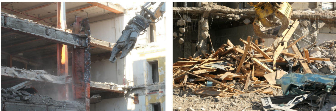
Abbildung 1: Gängige Praxis beim selektiven Abbruch; mechanisches Abschneiden von Stahlstützen (links) und aus einem Dachwerk herausgerissene Holzbauteile (rechts)
