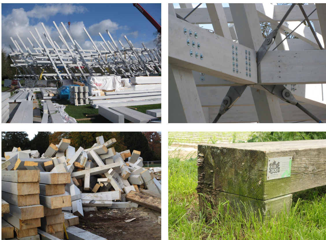
Abbildung 14: Montage des Pavillons im April 2015 (oben, links), Knotenpunkt (oben, rechts), selektiver Abbruch im November 2015 (unten, links) und Weiterverwendung als frei bewitterte Sitzbank, Mai 2023 (unten, rechts)
