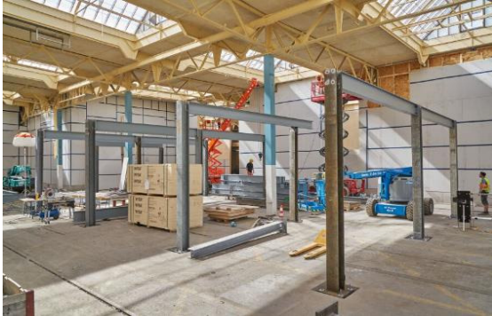
Abbildung 4: Galerietragwerk mit wiederverwendeten Stahlbauteilen (Quelle: baubüro in situ ag)
