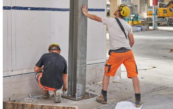
Abbildung 5: Wiederverwendung eines Stahlträgers mit angeschweißter Kopfplatte als Stütze (Quelle: baubüro in situ ag)
