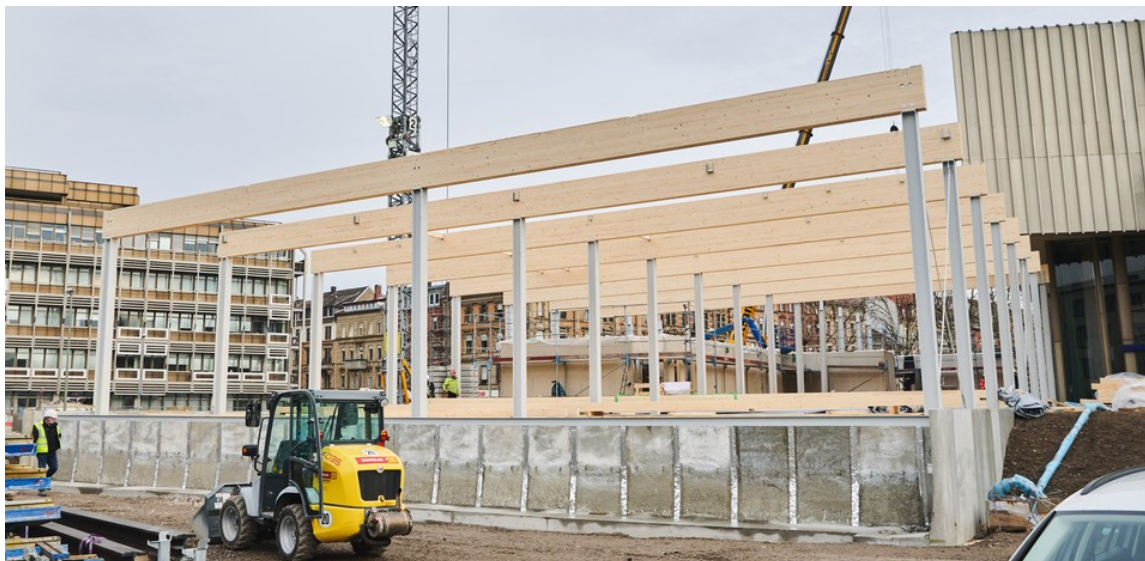
Abbildung 52: Provisorisches Entrée während des Umbaus des Badischen Staatstheaters, Quelle: Badisches Staatstheater Karlsruhe, Fotograf: Arno Kohlem
