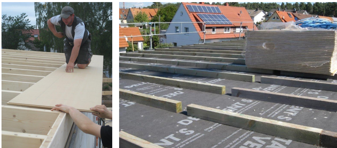
Abbildung 28: Im Jahre 2011 auf KVH-Sparren verarbeitete diffusionsoffene Holzwerkstoffplatten (links) und auf Konterlattungen vorgesehene OSB-Platten (rechts)
