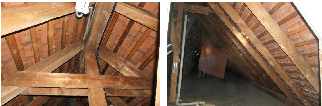
Abbildung 25 (Forts.) Firstsäule und Pfette (links) und Sparren (rechts)
