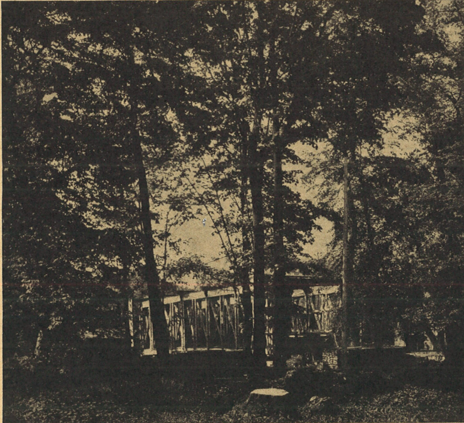
Hölzerne Straßenbrücke 1. Klasse von 32 m Länge mit zweispuriger unten liegender Fahrbahn im Bauhof der Versuchsanstalt für Holz, Stein und Eisen
