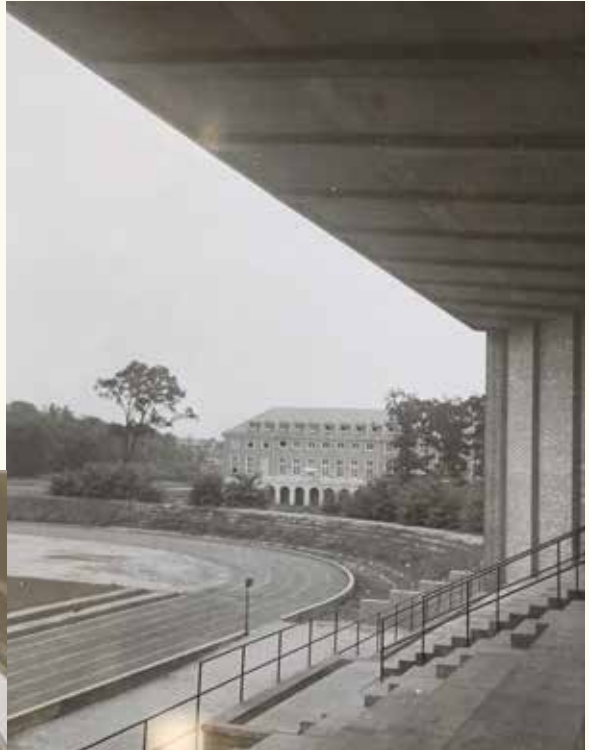
Die beeindruckende stützenlose Dachkonstruktion
