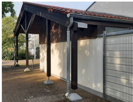
Bild 66: Prinzip zur Spritzwasserentlastung im Sockelbereich (links) und Ausführung (rechts)
