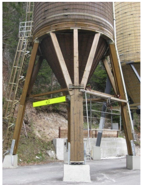
Bild 114: Beispiele für mögliche Feuchteanreicherungen in Stirnversätzen
