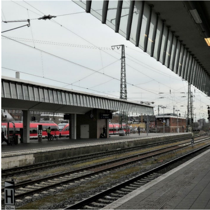
Bild 45: Schürzen an der Bahnsteigüberdachung, HBF Münster
