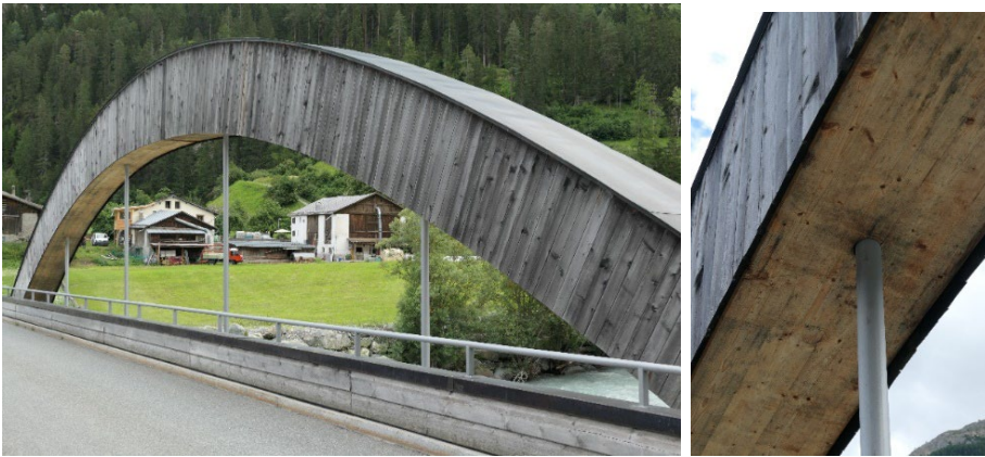
Bild 101: Ausführungsbeispiel für einen 3-seitigen Schutz nach dem Elementarprinzip; keine Durchdringung oder Manipulation der Bekleidung
