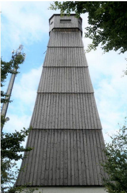
Bild 5: Sternbergturm, Gomadingen als Beispiel für konzeptionellen baulichen Holzschutz (links) und eine Gummidichtung unterhalb einer Scheibe an einer Rampenstütze der Rotary-Brücke, Schweiz als Beispiel für eine elementare Maßnahme (rechts)
