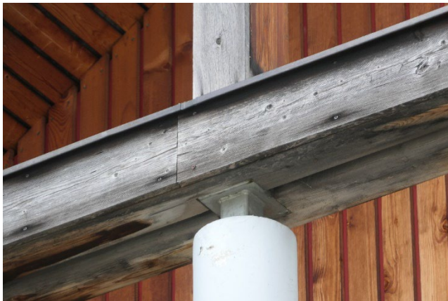
Bild 108: Gelungenes Ausführungsbeispiel für einseitig aufgeschraubte Opferbretter
