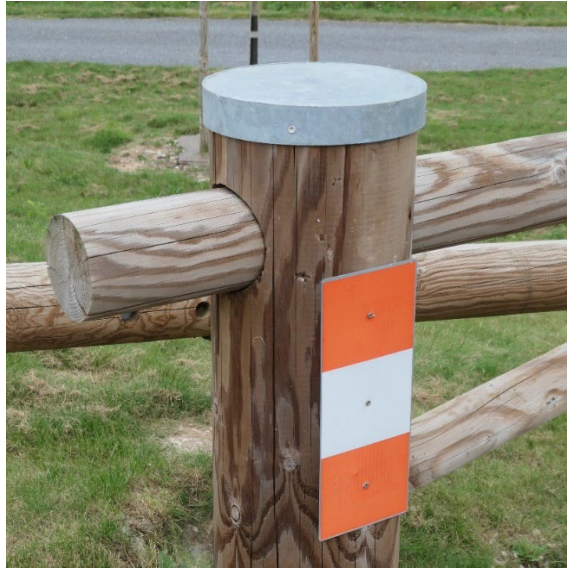
Bild 120: Ausführungsbeispiel einer vollkommenen oberseitigen Hirnholzabdeckung
