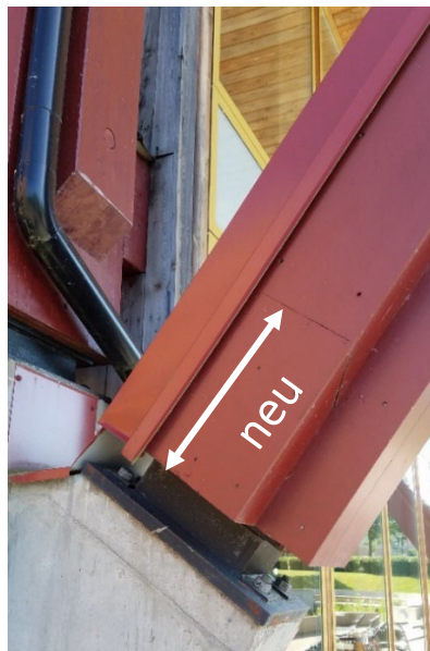
Bild 145: Repariertes Strebenende (neu) mit nachgerüstetem oberseitigen Abdeckblech einschließlich Wasserbremse zum Schutze gegen Spritzwasser
