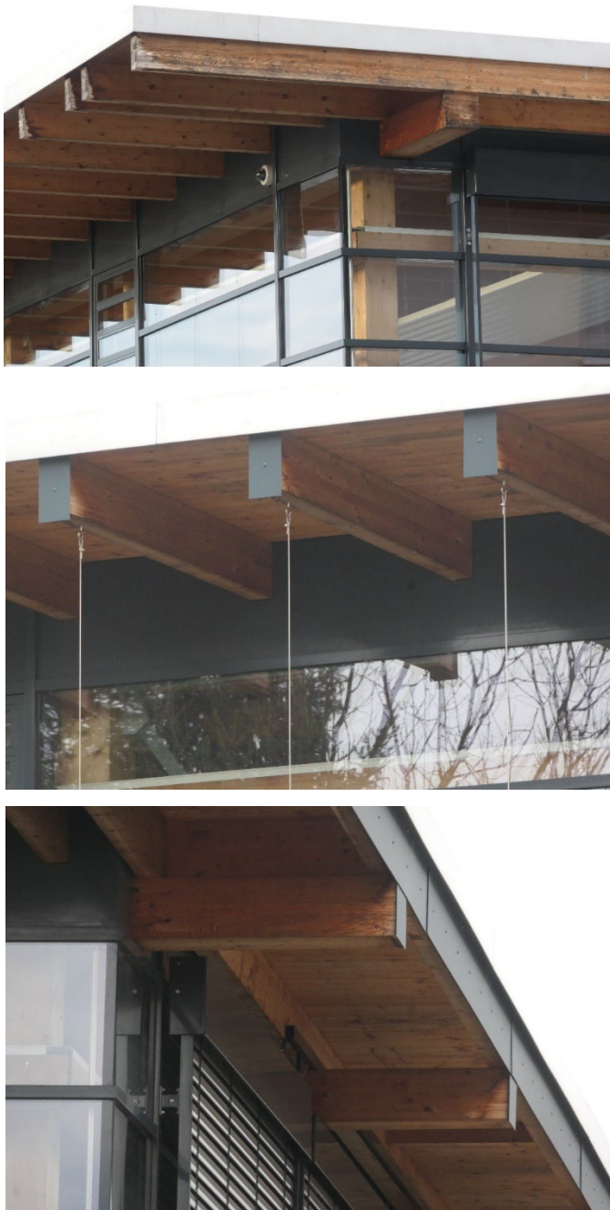
Bild 49: Acht Jahre lang bewitterte Trägerenden und Traufsparren (oben) und nachträgliche Bekleidung (mittig und unten)
