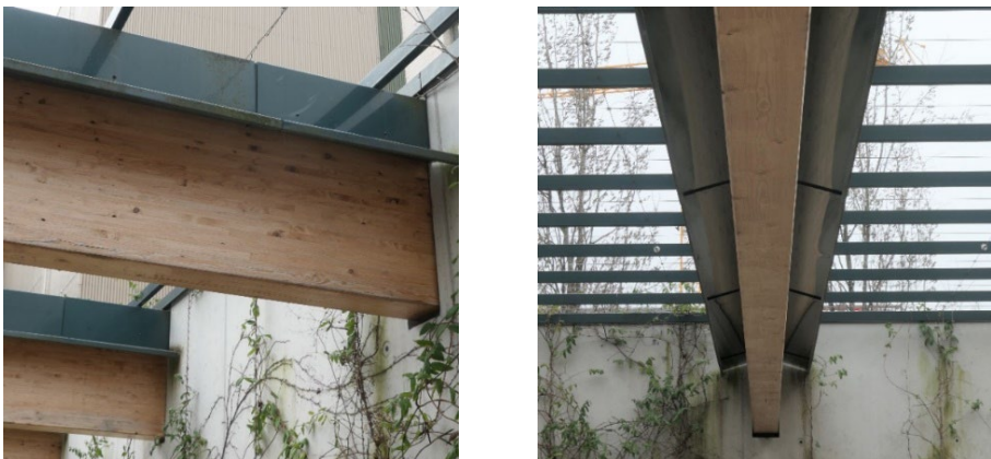
Bild 102: Ausführungsbeispiel für einen 3-seitigen Schutz nach \approx 60^\circ -Regel
