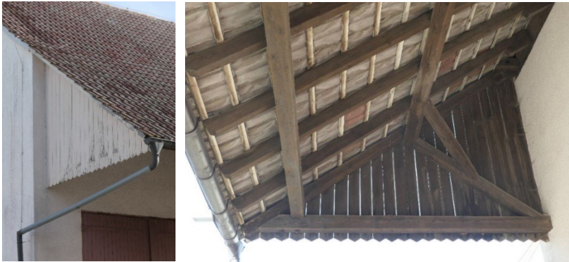
Bild 125: Ausführungsbeispiel für einen Wetterschutz
