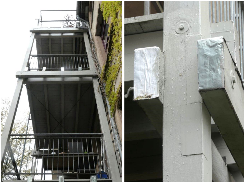
Bild 134: Beispiel für ein Sicherheitsrisiko: Holzbalkon für drei Obergeschosse (links) bereits mit lokalen Ausbesserungen an der Zange und diversen Beschichtungen (rechts)
