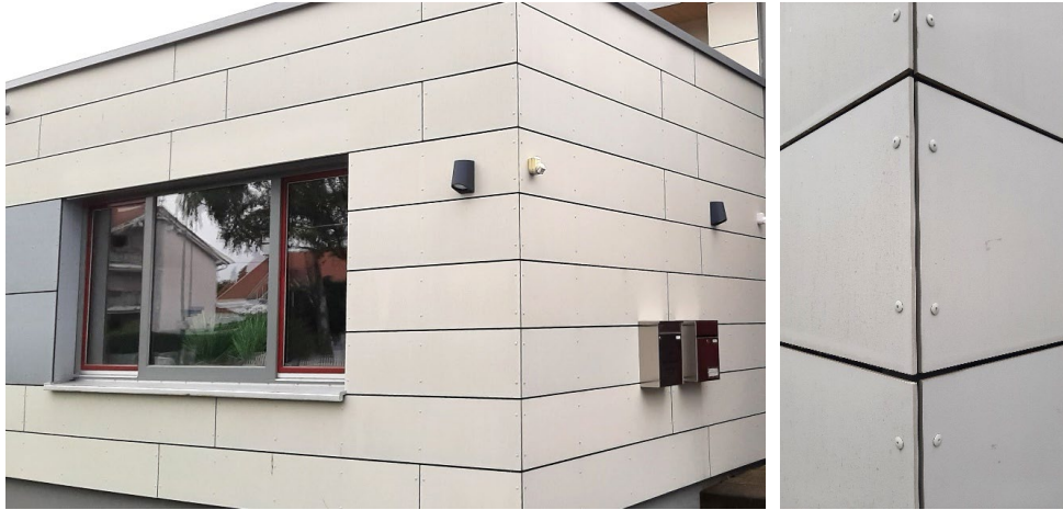
Bild 86: Fassadenplatten eines Holztafelbaus; Kirchengemeindehaus, Karlsruhe
