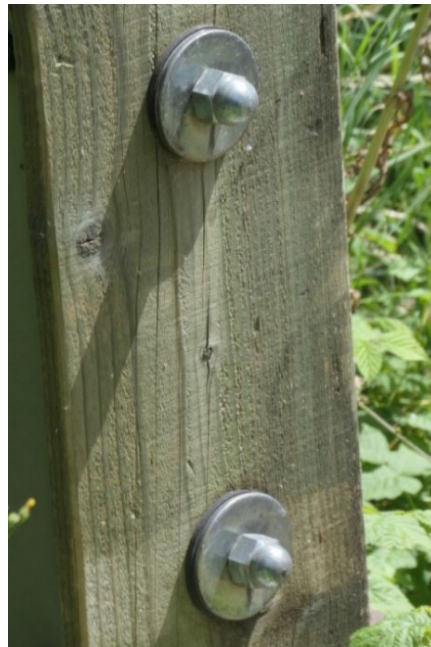
Bild 5: Sternbergturm, Gomadingen als Beispiel für konzeptionellen baulichen Holzschutz (links) und eine Gummidichtung unterhalb einer Scheibe an einer Rampenstütze der Rotary-Brücke, Schweiz als Beispiel für eine elementare Maßnahme (rechts)
