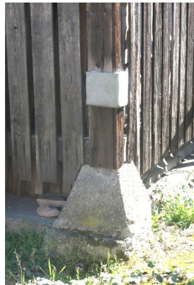
Bild 65: „Alte“ Ausführungsbeispiele für Vollholzstützen auf „hohen“ Sockeln
