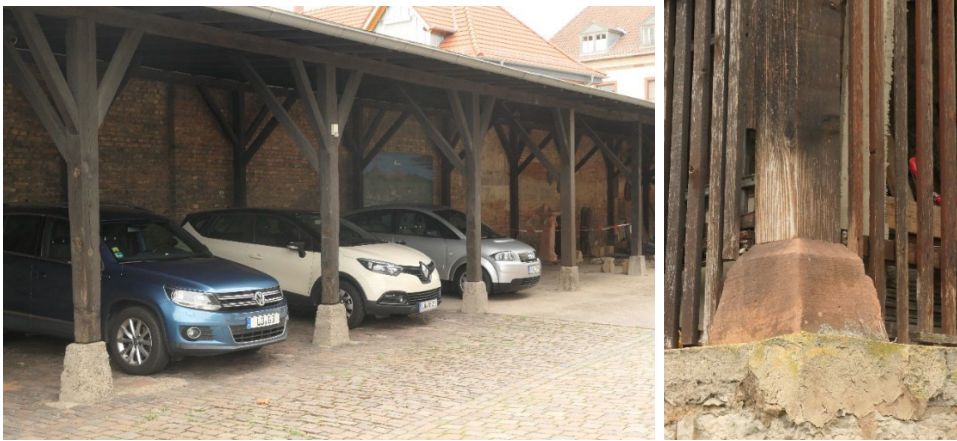
Bild 65 (Forts.): „Alte“ Ausführungsbeispiele für Vollholzstützen auf „hohen“ Sockeln
