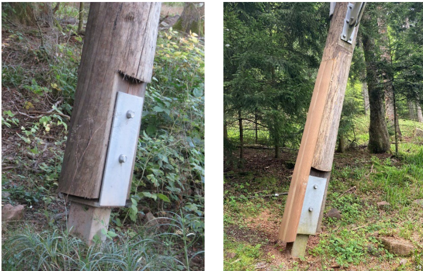
Bild 139: Stützenfuß eines Baumwipfelpfadbauwerks in GK 3.2; Originalzustand nach vier Jahren Standzeit (links) und nach neun Jahren bzw. nach Reparatur und Verbesserung des Hirnholzschutzes (rechts)
