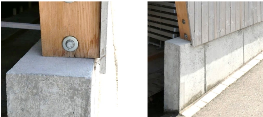
Bild 59: Gefahr von stehendem Wasser
