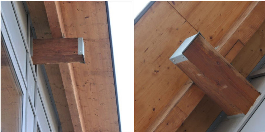
Bild 123: Ausführungsbeispiel eines Hirnholzschutzes unterhalb der Traufe
