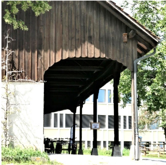
Bild 65: „Alte“ Ausführungsbeispiele für Vollholzstützen auf „hohen“ Sockeln
