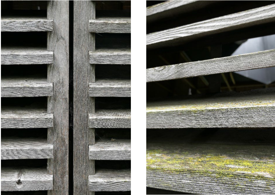
Bild 88: Ausführungsbeispiel für jalousieförmig angeordnete Bretter; Schutzbauten Welschdörfli
