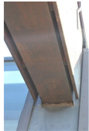
Bild 106: Ausführungsbeispiel für eine 3-seitige Bekleidung, Klima am Gardasee
