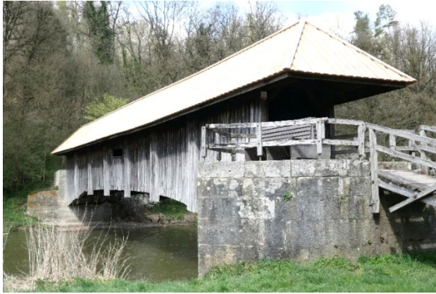
Bild 24: Ockenauer Steg über die Jagst, Baujahr um 1800, Dachhaut 2021 erneuert; ein Beleg für die Wirksamkeit von Maßnahmen des vorbeugenden baulichen Holzschutzes
