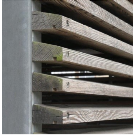
Bild 111: Ausführungsbeispiel für Lärchenleisten mit zusätzlicher Tropfkante, Alter etwa 13 Jahre
