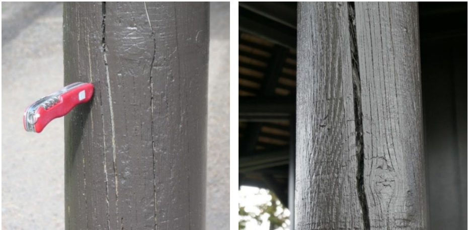
Bild 136: Fäulnis infolge Umkehreffekt (links) und Schwindriss (rechts)
