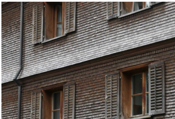
Bild 83: Mit Holzschindeln gestaltetes Abdach
