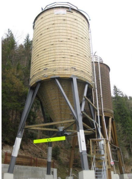
Bild 38: Neuer Salzsilo auf Stahlstelzen (im Vordergrund) im Vergleich mit einem älteren auf Holzstelzen (im Hintergrund)
