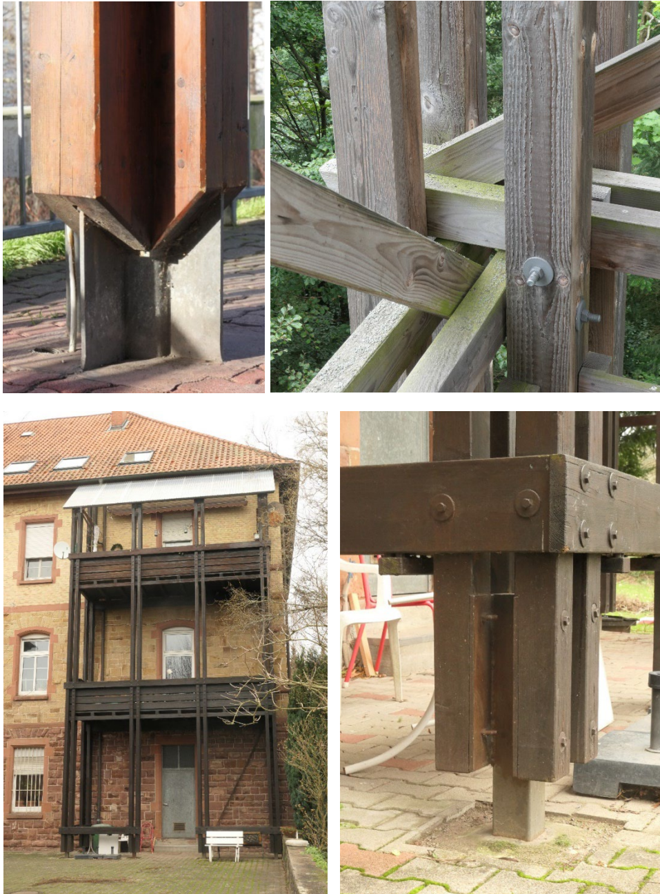
Bild 74: Ausführungsbeispiele einer fünfteilig ausgeführten BS-Holz-Stütze (oben links) und vierteiliger, gespreizter Stützen eines Turmes (oben rechts) und einer Balkonanlage (unten)
