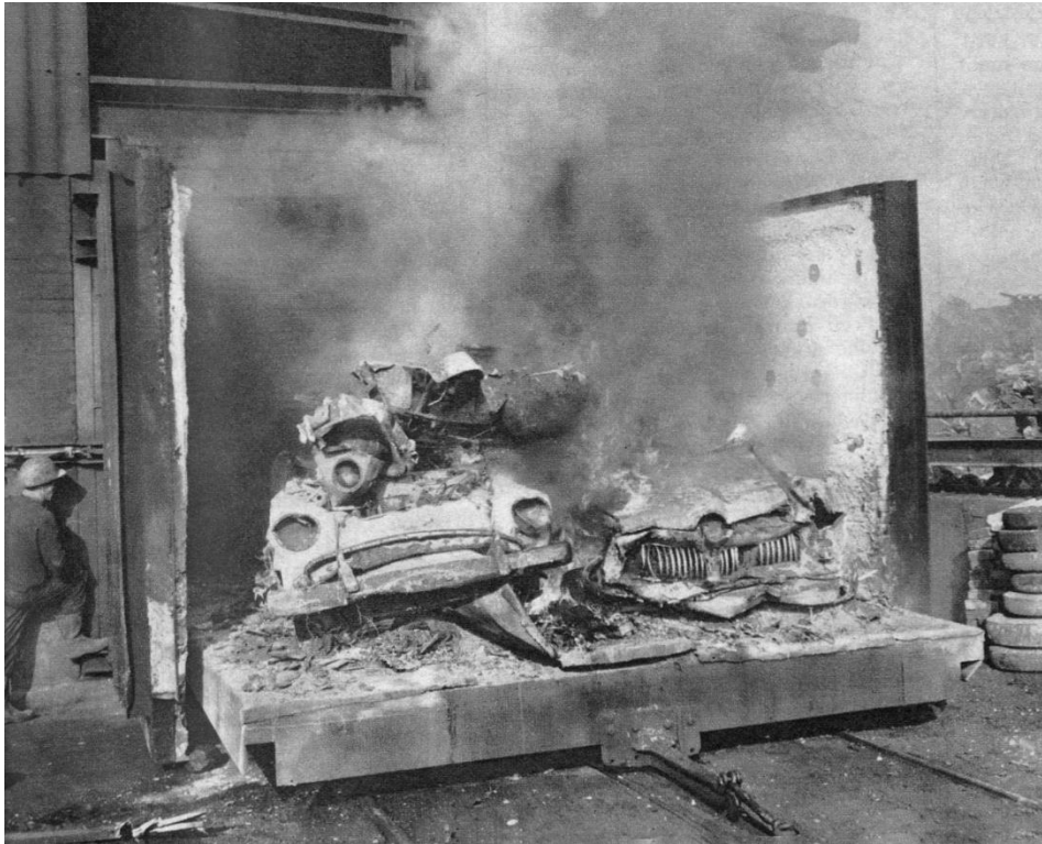
Abbildung 16: Karosserieausbrennöfen zum schadstoffarmen Ausbrennen nichtmetallischer Bestandteile von Autowracks etablierten sich nicht dauerhaft am Markt. Anlage in Nürnberg 1968. auto motor und sport (1968) H. 15, S. 11.
