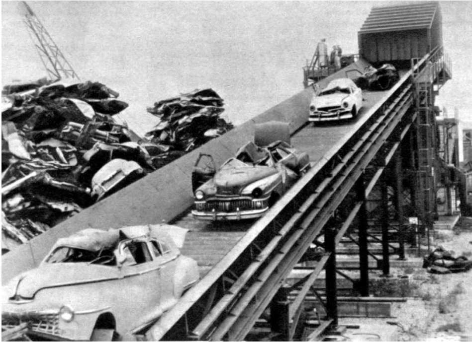
Abbildung 9: Automatisierte Demontage von Fahrzeugen zur Rückgewinnung von verwertbarem Eisen und Stahl: Automobilshredder der amerikanischen Firma Luria Brothers. auto motor und sport (1964) H. 19, S. 3.
