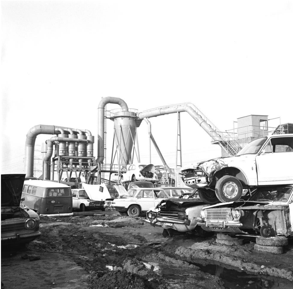
Abbildung 15: Staubfreie Shredderanlage mit Zyklon-Entstauber (links) und Transformatorstation (rechts) auf einem Schrottplatz in Oststeinbek. Kreisarchiv Stormarn, I 1 / 35806.
