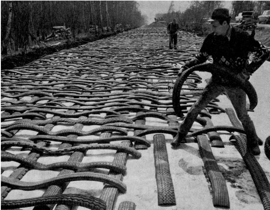
Abbildung 21: Altreifen als Unterlage für den Bau einer Landstraße in Oberbayern, 1977. ADAC motorwelt (1977), H. 9, S. 10.
