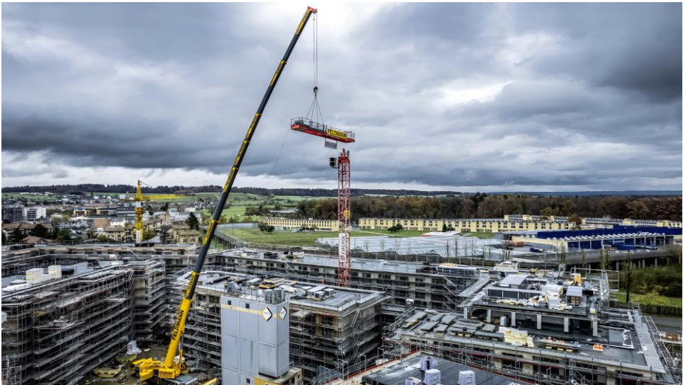
Abbildung 1.1: Moderner Mobilkran mit Teleskopausleger aus ultrahochfesten Feinkornbaustählen [Lieb23]
