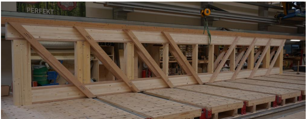
Abbildung 1: Fachwerkträger mit außenliegenden Zuglaschen auf dem Abbundtisch
