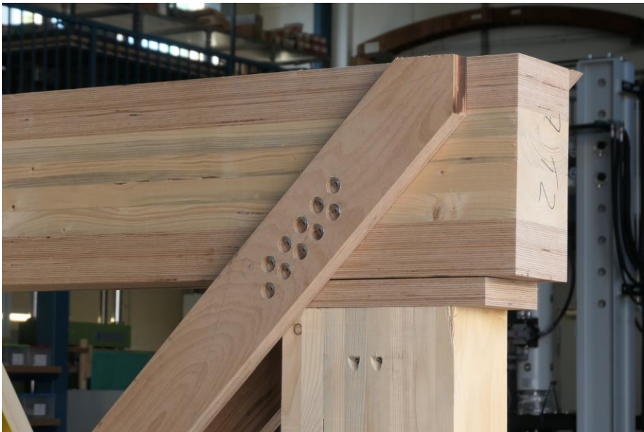
Abbildung 4: Knotenpunkt mit geneigt eingebrachten Schrauben
