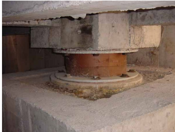
Abbildung 143: Erdbebenisolation mittels Elastomerlager [164]
