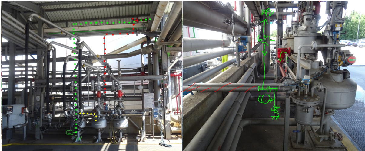
Abbildung 4 Anpassung der Verrohrung zur Integration der Komponenten der Blendanlagen
