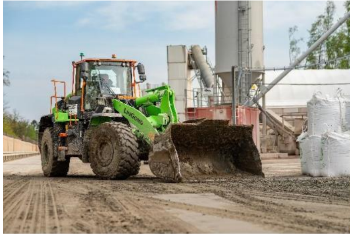
Abb. 6: Elektrischer Radlader im Testbetrieb auf der Baustelle U5 Ost
