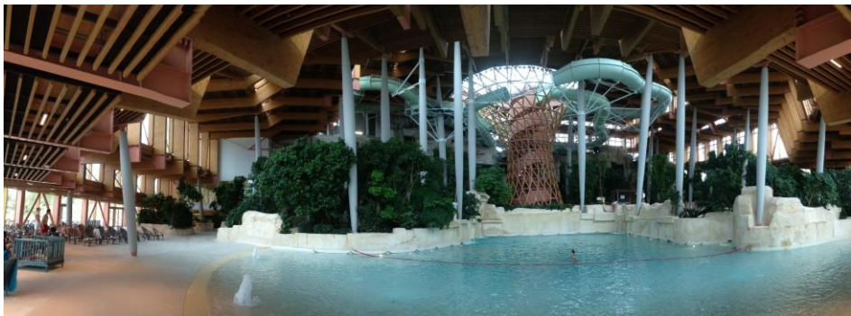
Abbildung 8.7: »Aqualagon« im »Villages Nature® Paris« von »Jacques Ferrier« als Beispiel für Stützen mit nichtlinearer Verjüngung des Stützenquerschnitts in UHFB-Bauweise
