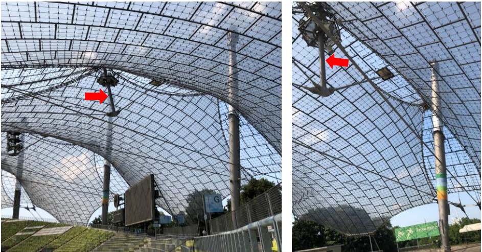
Abbildung 8.6: Reale Ausführung der »Luftstützen« im Dachtragwerk des »Olympiastadion München« als konstantes Kreishohlprofilrohr
