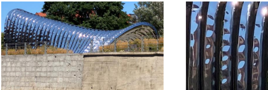
Abbildung 1.7: Architektonische Skulptur »NAWA« (von »Zieta« bzw. »Zieta Prozessdesign«) mit dem für das »Die-Less-Hydroforming« typischen Beulmuster als Beispiel für eine Architekturanwendung
