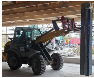
b) Nutzung vorhandener Transportanker
