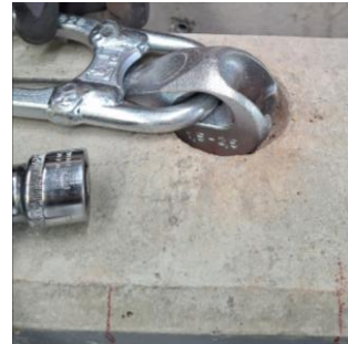
c) Nachträgliche Anbringung von Transportankern
