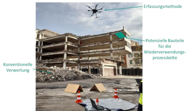
Anhang A1 3-4: Beispielhafte Anwendung von Drohnentechnik zur Geometrieerfassung [IMB-MB]
