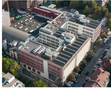
(b) Beispielhafte Photovoltaikanlage in NAP 6 mit 119,29 kWp, mit einer Ost-West-Mischausrichtung. Entnommen aus einer Drohnenaufnahme [193].
