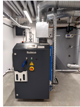
(d) Beispielhaftes BHKW in NAP 4 vom Typ Buderus Loganova EN 20 (eigene Aufnahme).
