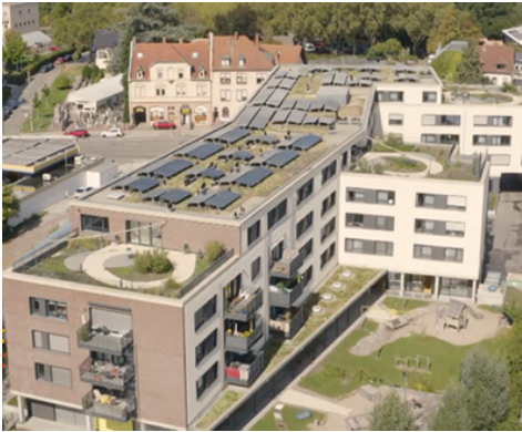
Abbildung A.8.: PV-Anlage von NAP 4 mit 99 kWp, Ost-West-Mischausrichtung. Entnommen aus einer Drohnenaufnahme des Reallabors Smart East [193].
