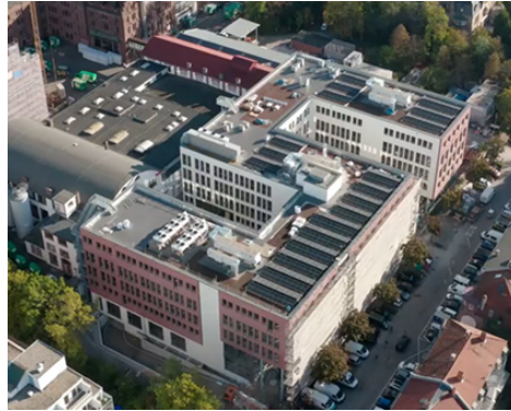
Abbildung A.9.: PV-Anlage von NAP 6 mit 119,29 kWp, Ost-West-Mischausrichtung. Entnommen aus einer Drohnenaufnahme des Reallabors Smart East [193].
