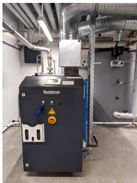
Abbildung A.14.: Das Buderus Loganova EN 20 BHKW in NAP 4 (eigene Aufnahme).
