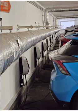
(c) Beispielhafte Ladeinfrastruktur von NAP 4 im Innenbereich vom Typ ChargeX Aqueduct (eigene Aufnahme).
