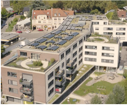
(a) Beispielhafte Photovoltaikanlage in NAP 4 mit 99 kWp, mit einer Ost-West-Mischausrichtung. Entnommen aus einer Drohnenaufnahme [193].
