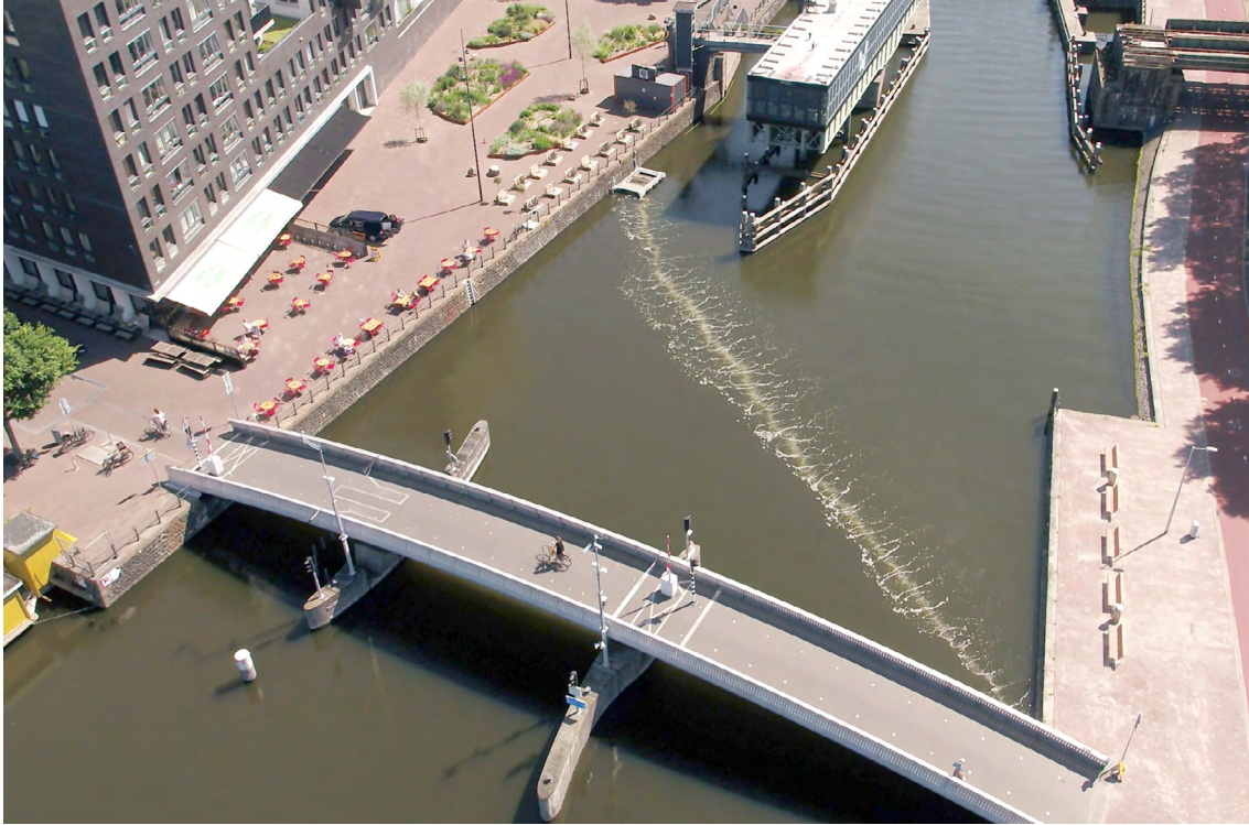
Abbildung 5.4 Luftblasenvorhang in Amsterdam
