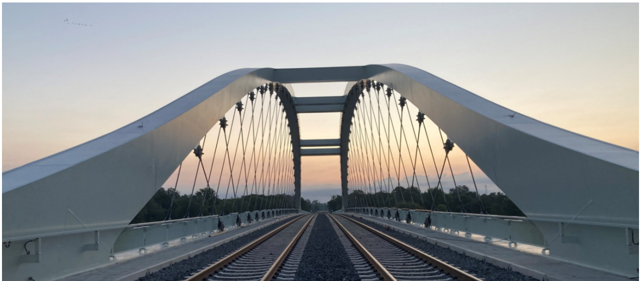
Abbildung 1-1 Zweigleisige Netzwerkbogenbrücke über die Oder bei Küstrin mit Zuggliedern aus Carbon. Inbetriebnahme Juli 2024.
