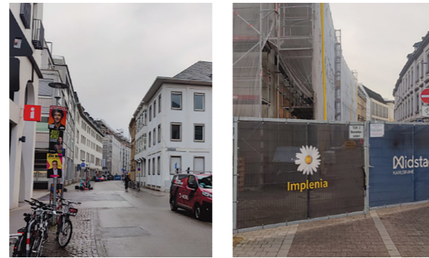
Abb. 65. Baustelle im hinteren Bereich des Zirkels
