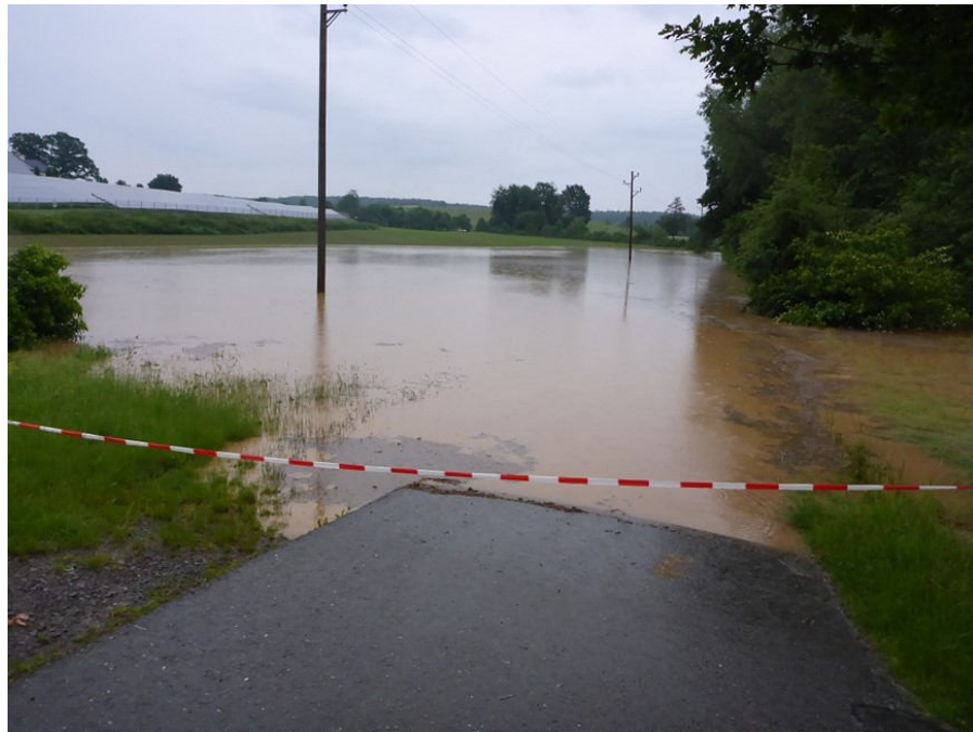
Figure B.10: Impact of flash floods on 08.06.2016 over Elsenz Schwarzbach (Image credit: Zweckverband Hochwasserschutz Elsenz-Schwarzbach)
