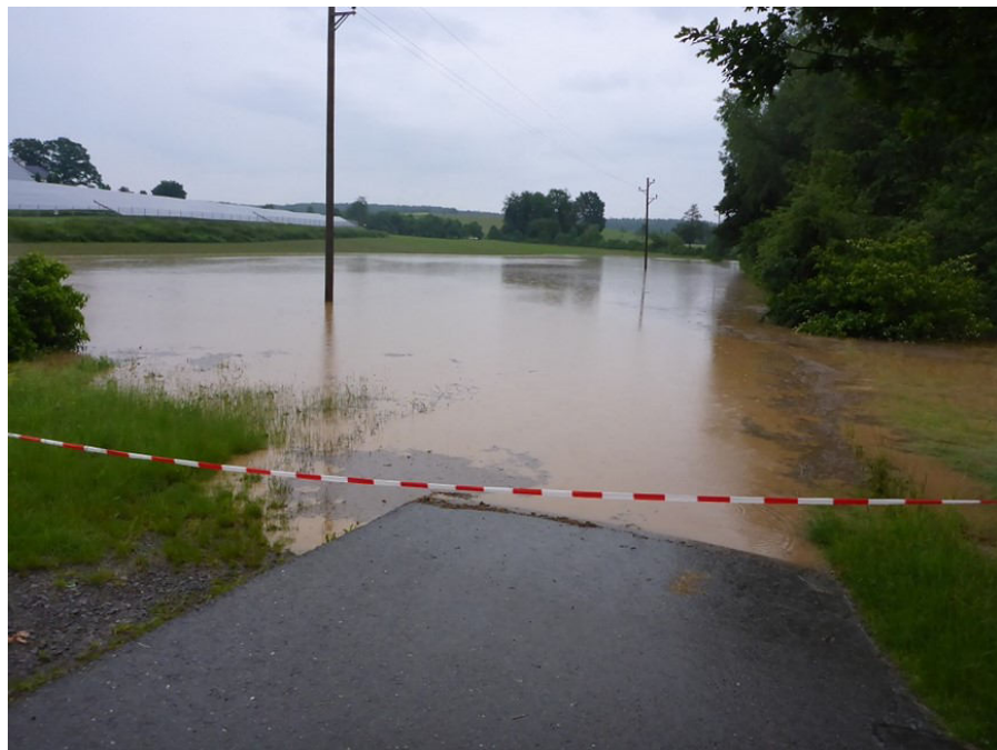
Figure A.5: Impact of flash floods on 08.06.2016 over Catchment W22 (Zweckverband Hochwasserschutz Elsenz-Schwarzbach, 2016).
