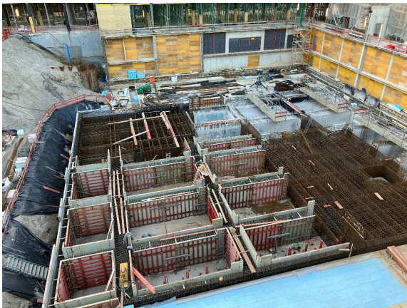
Abb. 22: Kammerfundament Hochhaus zweiter Bauabschnitt
