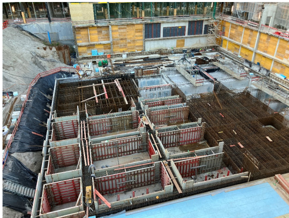
Abb. 22: Kammerfundament Hochhaus zweiter Bauabschnitt
