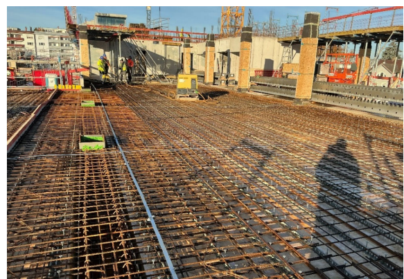
Abb. 23: HBV-Deckenmontage
