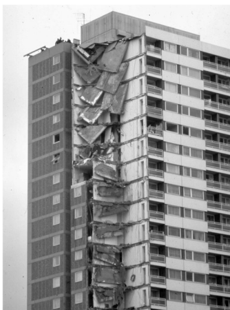
Abb. 1: Progressives Versagen des Wohngebäudes in Plattenbauweise Ronan Point [2].
