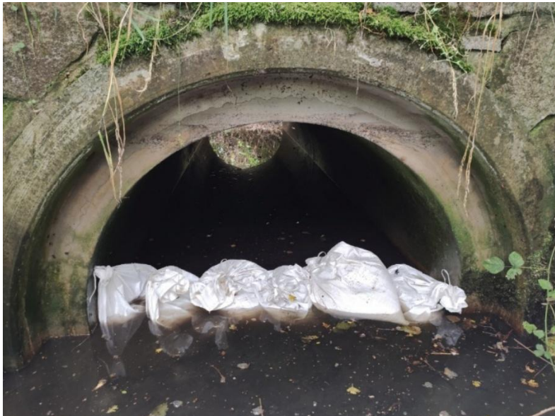
Abb. 46: Rohr Stau 3 'Deponieecke' mit flachem Verschluss aus Sandsäcken
