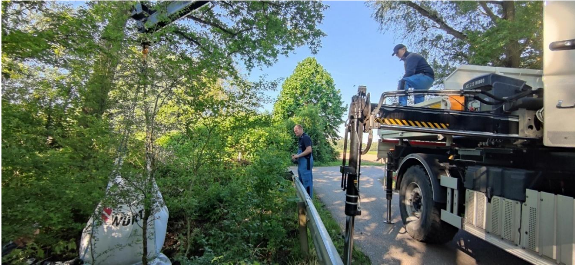
Abb. 40: Einbau des ersten BigPack-Staus am Hauptgraben ,Im Rheinfeld‘
