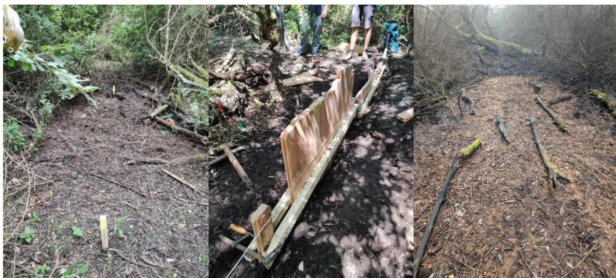
Abb. 45: Standort Holzstauwand vor der Umsetzung, im Bau und nach der Umsetzung
