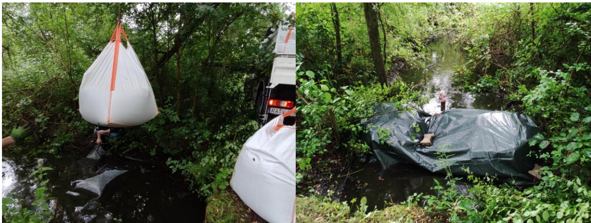
Abb. 43: Einbau Stau 2 und fertiger Stau
